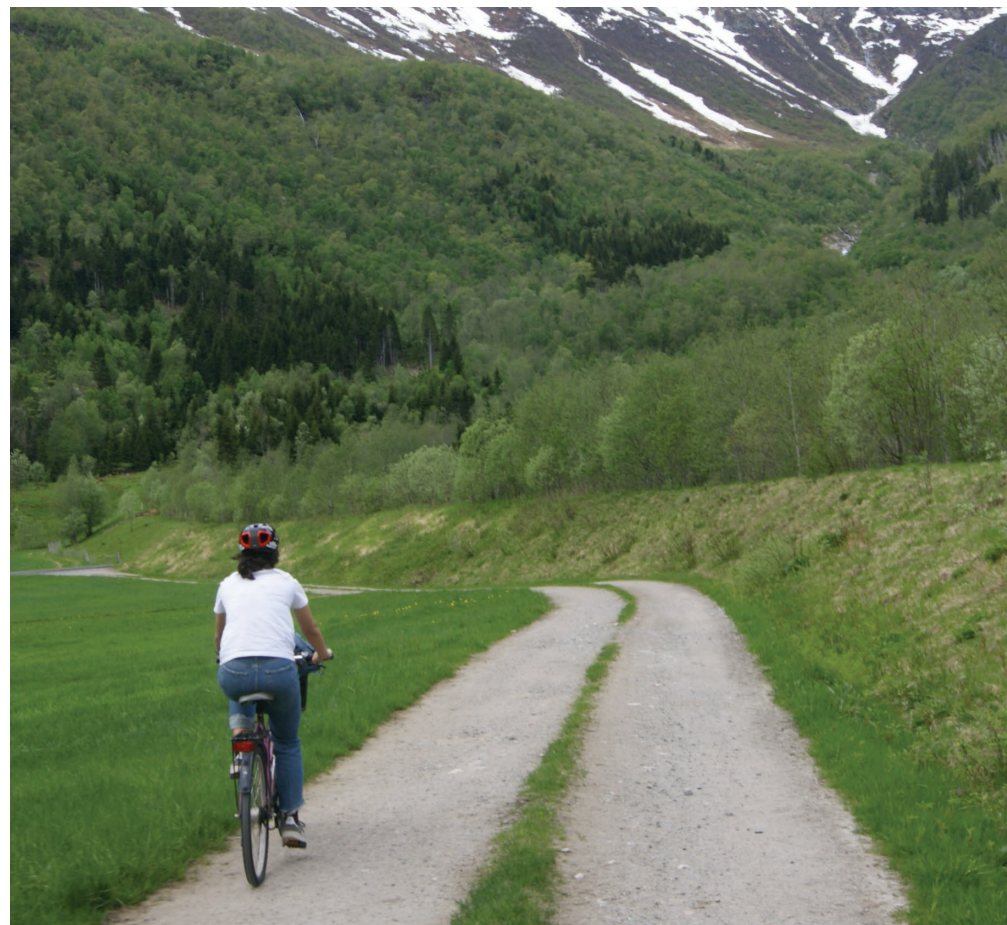
Figur 54: Traktorveiene utbedres slik at de får den originale utformingen med grusunderlag, mai 2021.
