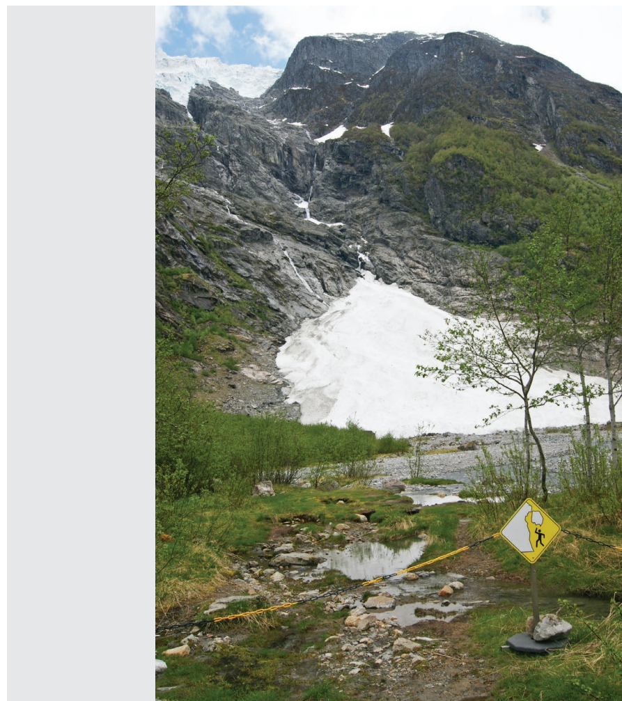
Figur 40: Grusveien går i oppløsning og kjettingen som skal hindre ferdsel opp til breen er lite bestandig mot naturkreftene, mai 2021.
