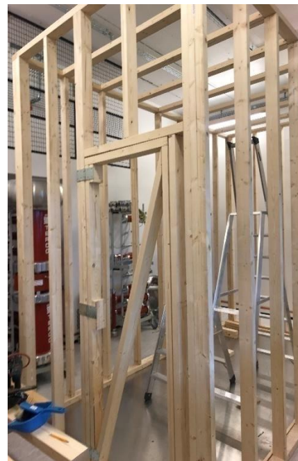
Figur 10: Rammen ferdig montert
