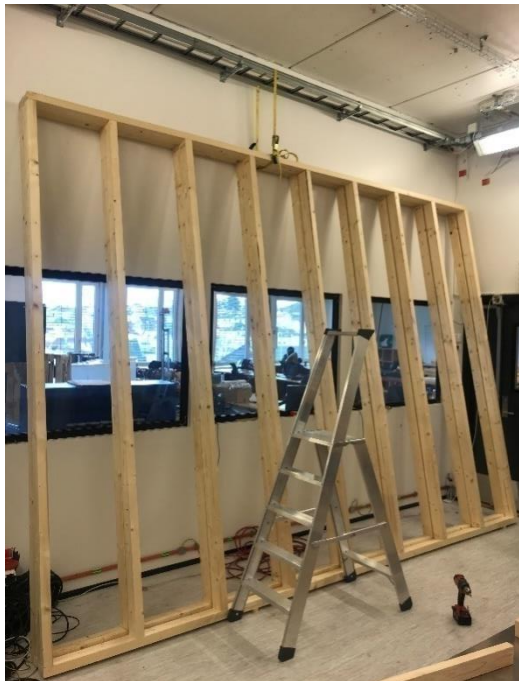
Figur 11: Bygging av vegg til Faradaybur
