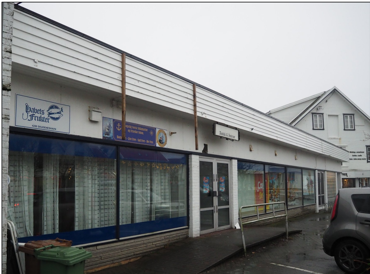
Figur 11: Den tidligere næringsbygningen på Torget 4. Bilde: Merkesvik, 2020.
