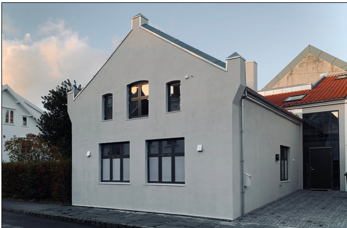
Figur 10: Bakeriet i Kaigata 10 etter ferdigstilling. Bilde: Olsen, 2020.
