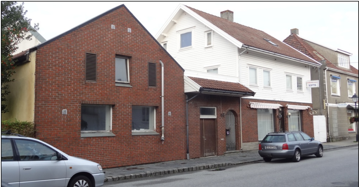
Figur 9: Fasadene til bakeriet i Kaigata 10 og bakeriutsalget i Kaigata 12 har gjennomgått en god del endringer oppgjennom 1900-tallet. Bilde: Wiik, 2014.
