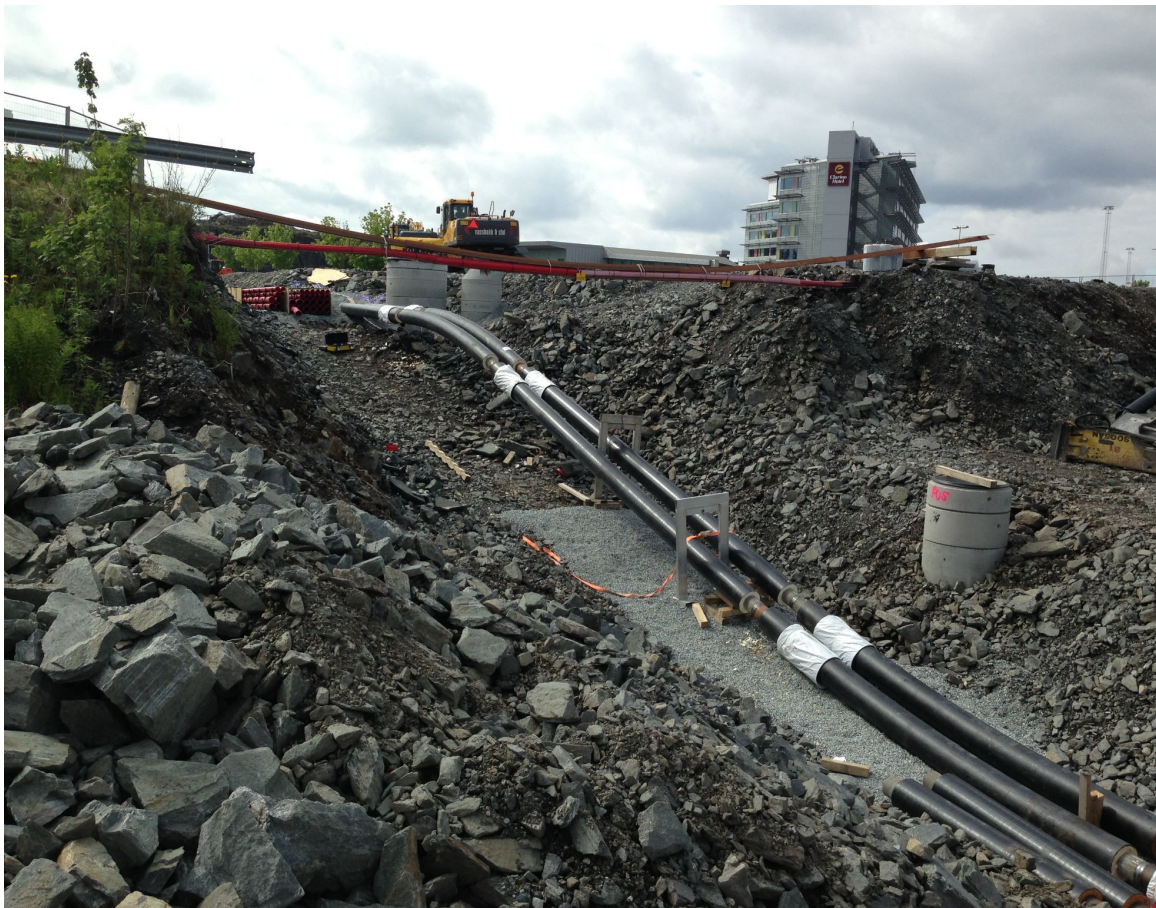
Figur 1: Bilde av fjernvarmerør i grøft, foto fra BKK Varme internt. (tillatelse til bruk i oppgaven)
