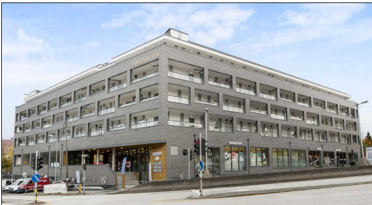
Figur 48: Paradisalléen ferdigstilt bebyggelse og fasade. Foto: privat
