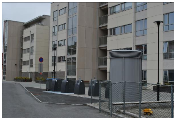
Figur 34: Wergeland Terrasse ferdigstilt avfallshåndtering. Foto: privat
