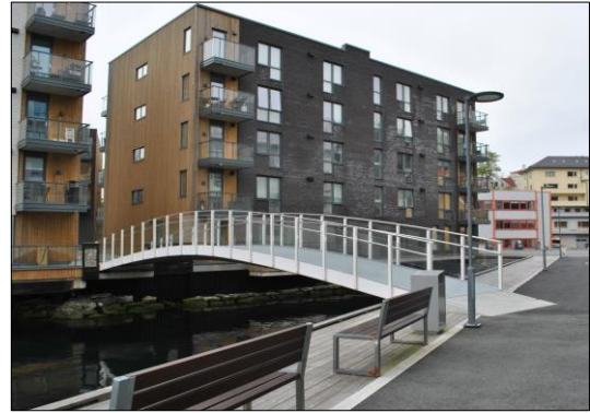
Figur 59: Nyhavn ferdigstilt gangbro. Foto: privat
