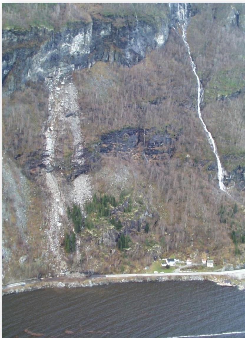
Foto: Svein Helge Frækaland – skred mellom Erdal og Lærdal.
