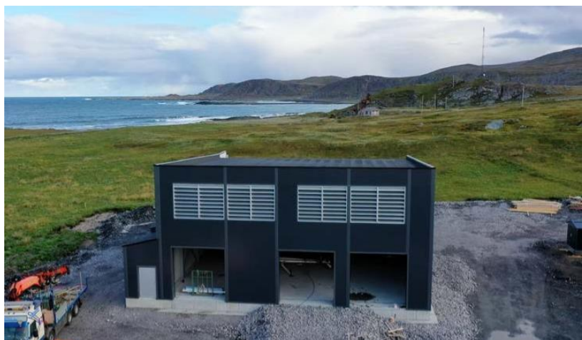
Figur 9: Ferdigstilt bygg for Haelous-prosjektet 2019 [104].
