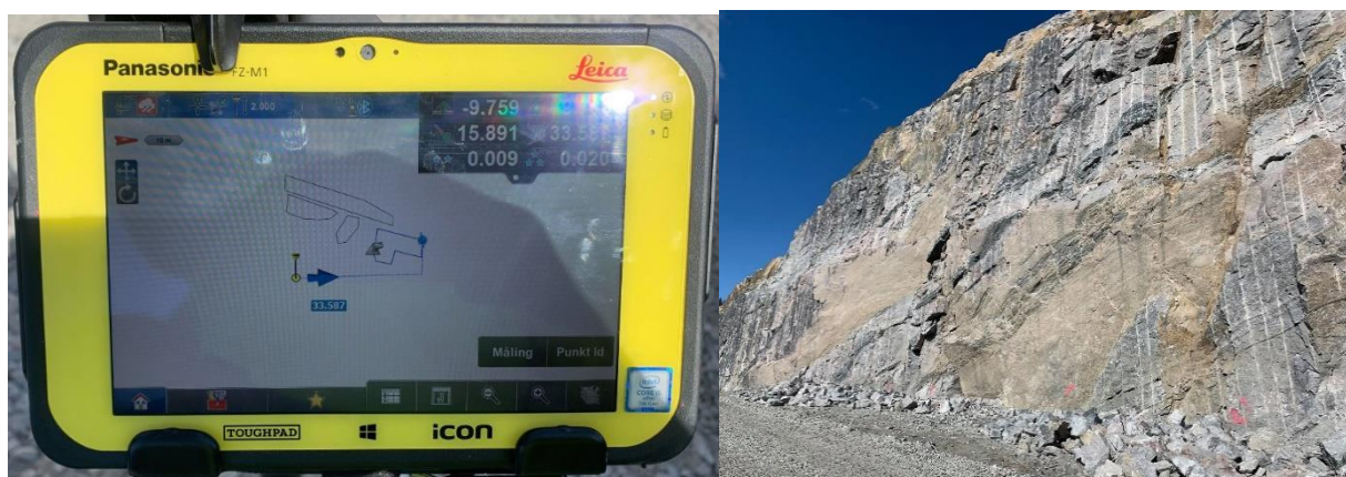
Figur 13: Til venstre ser vi et eksempel på markeringer av knøler på en Leica FZ-M1 målebok; til høyre ser vi en skjæring som er to paller høy med rosa spraymarkeringer for hvor noe stikker ut som må fjernes. Bildene er tatt ute på anlegget ved et tidligere tidspunkt.
