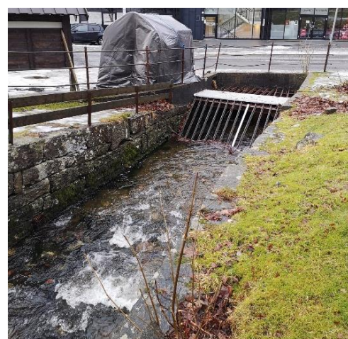
Figur 41 Enden på Landåsbekken
