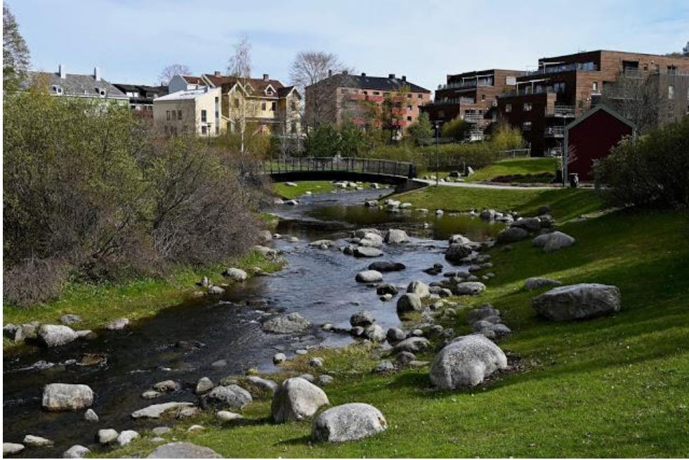
Figur 71 Viser Ilabekken gjenåpnet med en naturlig utforming- Huges
