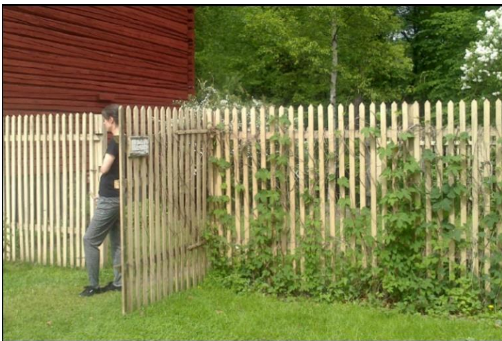
Figur 51 Her blir det illustrert hvordan man kan unngå at beboerne stopper opp med porten ved at gjerde og port glir sammen (Bar Bakke landskapsarkitekter , u.d.).
