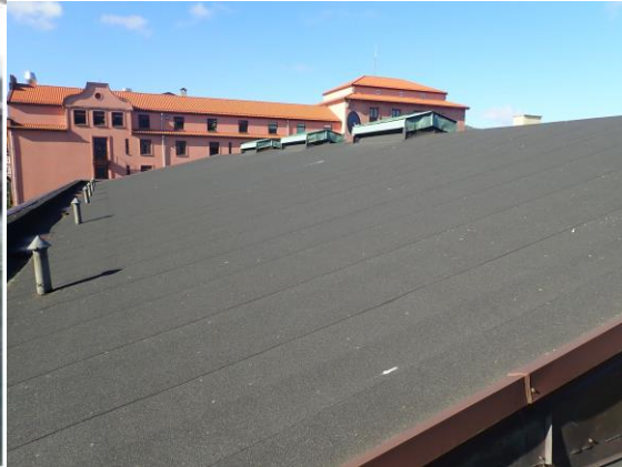
Figure 22: Yttertak over høyblokken. Tilsendt fra Asplan Viaks befaring i 2019.
