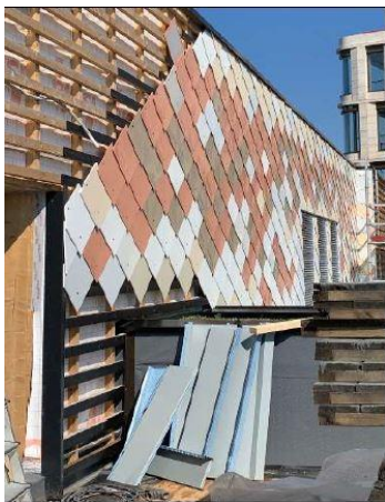
Figure 54: Bilde av fasadeplater under montering fra Kristian Augusts gate 13, Oslo [132].
