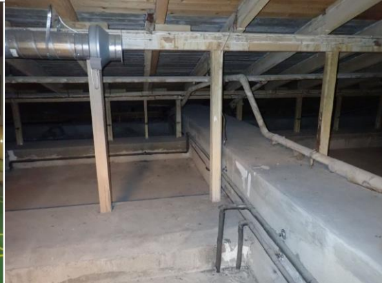
Figure 41: Trevirke i taket på høyblokken. Tilsendt fra Asplan Viaks befaring i 2019.
