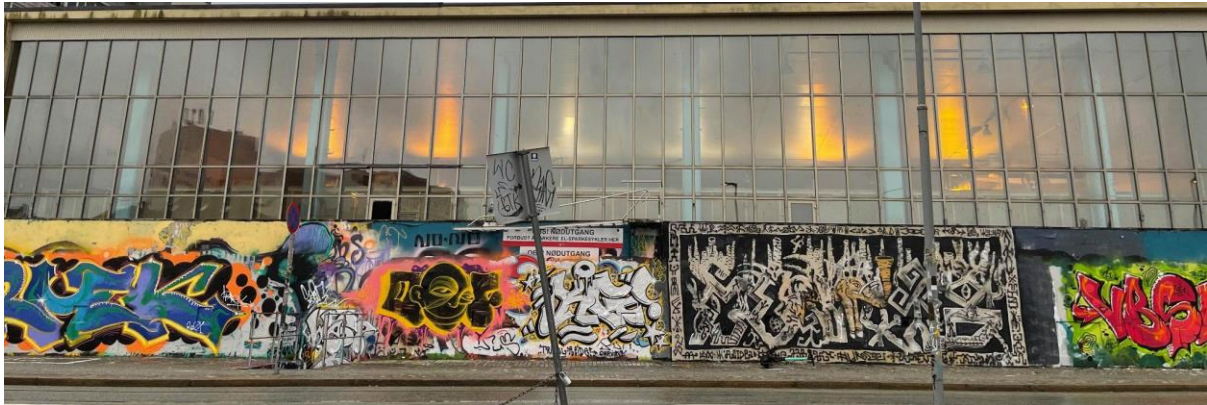
Figure 21: Glassfasaden mot Nordvest i Sentralbadet 4. April 2021.
