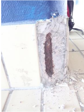
Figure 60: Søyler mellom nautilus treningsrom og svømmehall. Tilsendt fra Asplan Viaks befaring i 2019.
