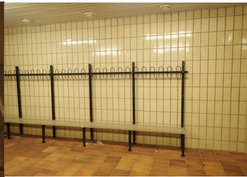
Figure 37: Bilde av flislagte garderobe vegg i sentralbadet. Tilsendt fra Asplan Viaks befaring i 2019.
