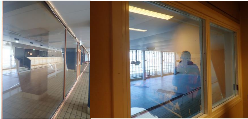
Figure 39: Innvendige vindu mellom nautilus treningsrom og svømmehall. Tilsendt fra Asplan Viaks befaring i 2019.
