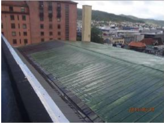
Figure 23: Yttertak over svømmehallen til Sentralbadet [56, s. 87].
