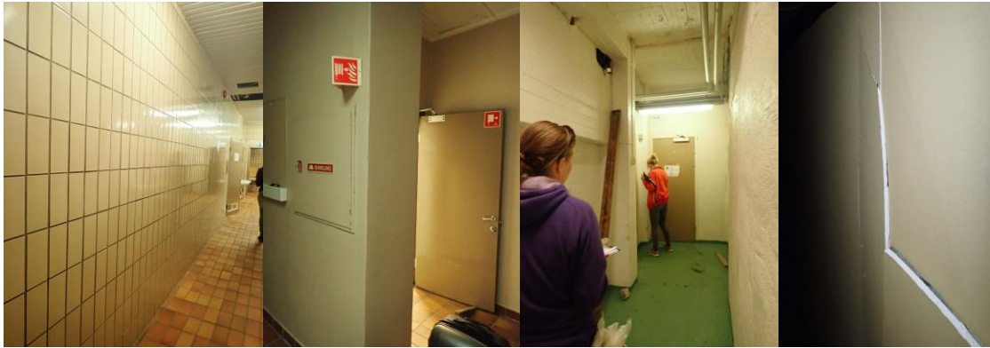
Figure 25: Innvendige flislagte vegger i Sentralbadet. Tilsendt fra Asplan Viaks befarings i 2019.
