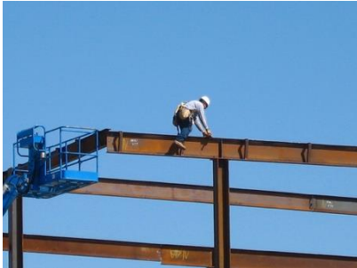
Figur 6 - Stål på byggeplass [97]
