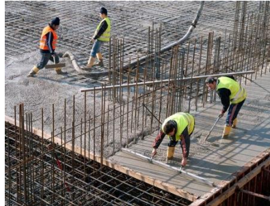
Figur 5 - Betong på byggeplass [98]
