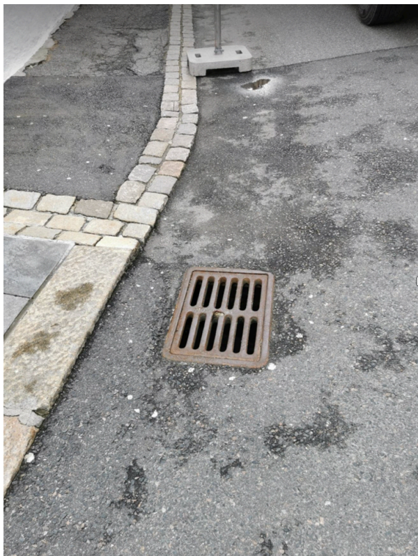
Figur 29 - Uheldig situasjon med sluk i bunnen av infiltrasjonssystemet, privat
