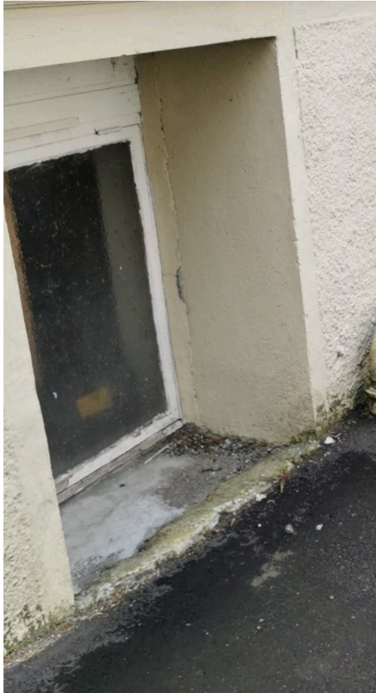
Figur 12 - Alternativ overvannsavledning foran vinduene som tydelig bærer preg av fukt og råte, privat
