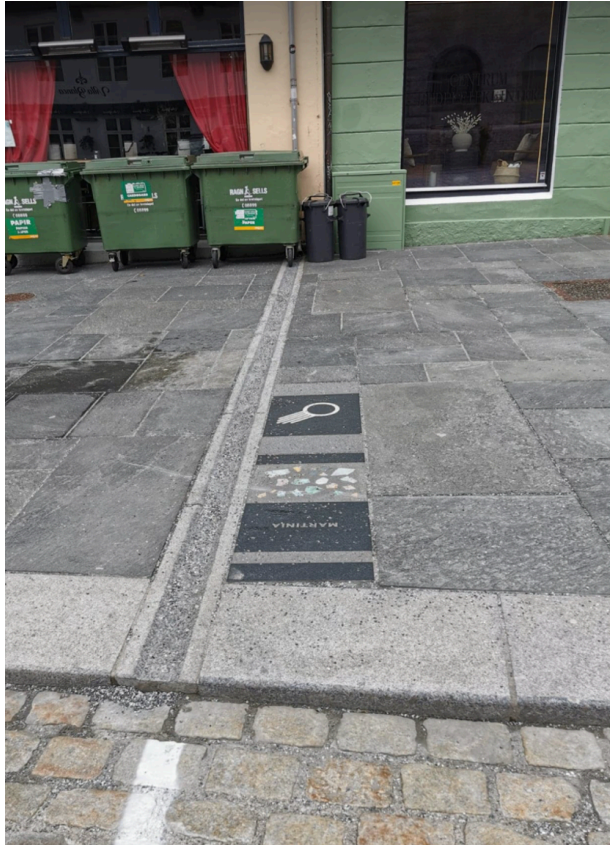
Figur 26 - Alt takvann fra omkringliggende bygg føres på samme måte ut over gangarealet og ut i veiflaten, hvor det renner til nærmeste sluk og ned i infiltrasjonsanlegget, privat
