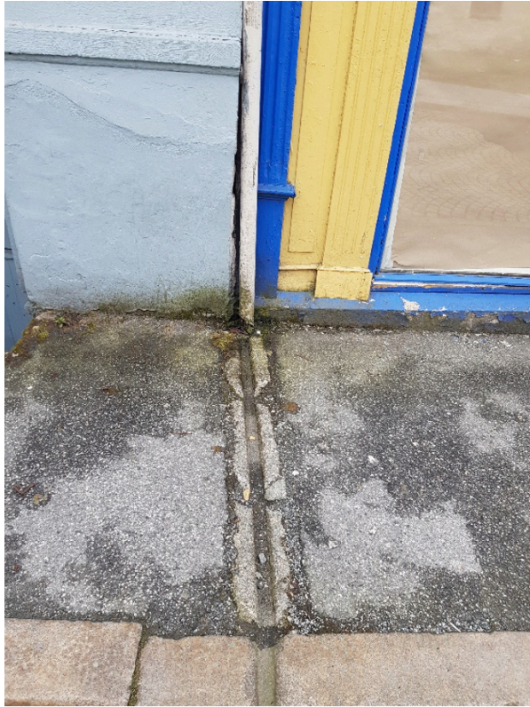
Figur 19 - Frakoblede taknedløp i dårlig forfatning med tette utspylere ut til kantsteinen, privat
