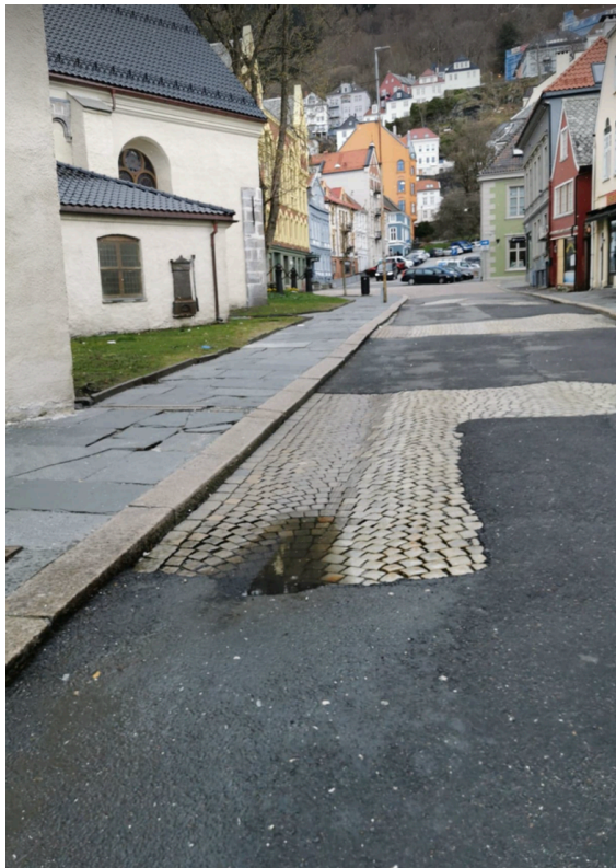
Figur 22 - Slitt og dårlig dekke hvor det har tendens til å samle seg vann, privat
