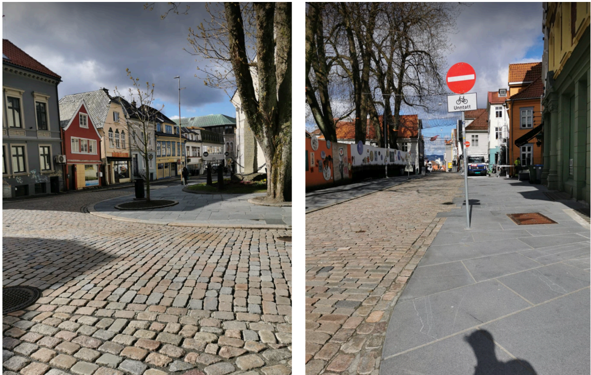
Figur 15 - Kong Oscars gate i kryssningen ved Øvre- og Nedre Korskirkeallmenningen (venstre) og nordgående retning (høyre), privat
