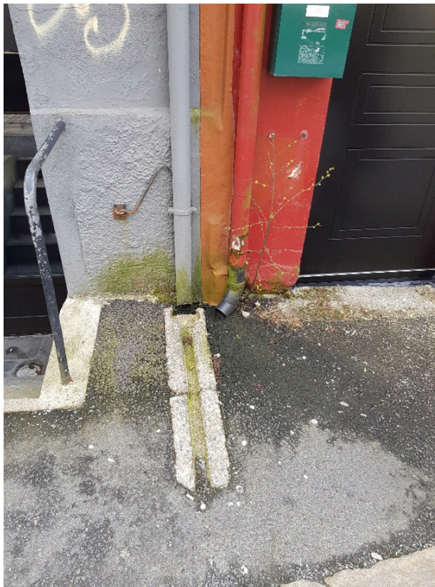
Figur 18 - Frakoblede taknedløp med tette utspylere ned og ut over kantsteinen, privat
