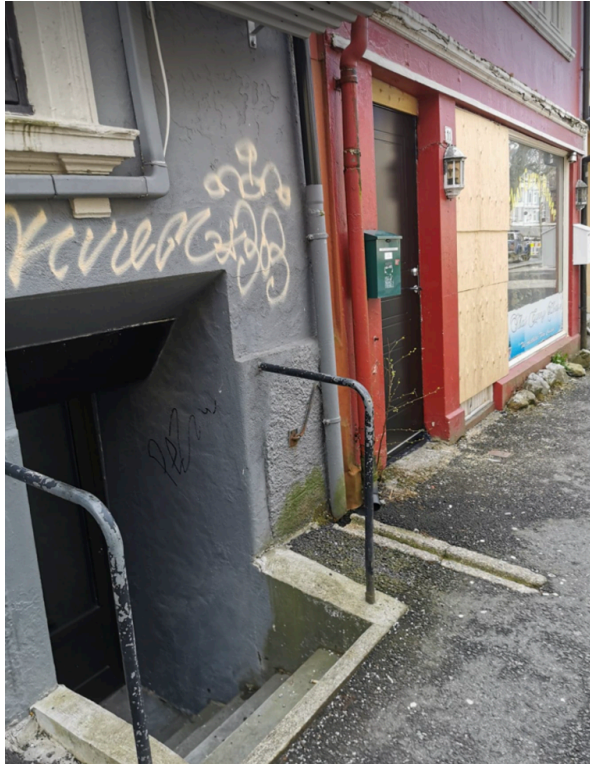
Figur 21 - Kjellernedgang med tegn til fukt (høyre). Taknedløp tilkoblet avløp-fellesledningen (venstre), privat
