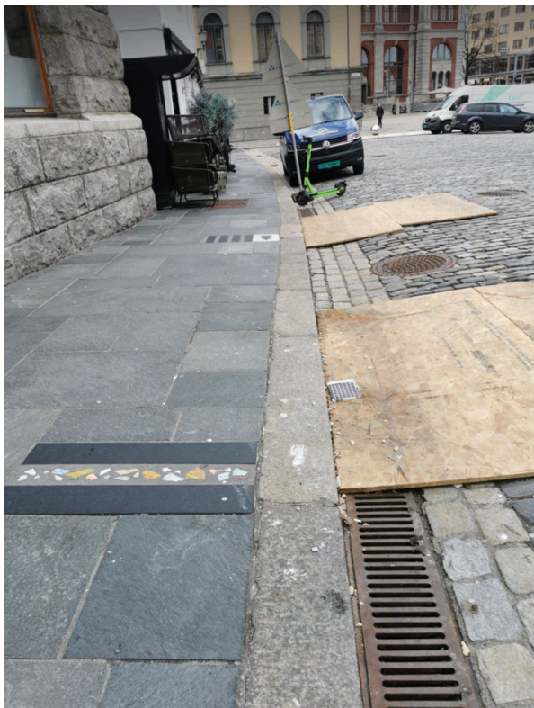
Figur 27 - Ristsluk langs kantsteinen rundt hele anlegget, markering på skifer illustrerer plasseringene til de ulike bentonittpluggene/bentonittdemningene, privat
