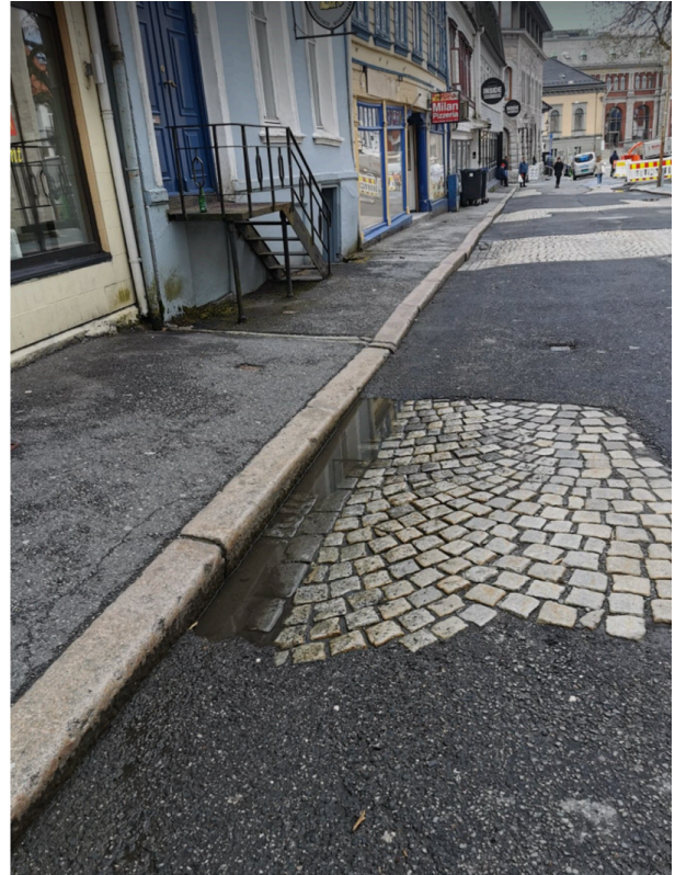
Figur 17 - Slitt og dårlig dekke som viser store tegn til setninger, og ingen sluk før i bunnen ved infiltrasjonsanlegget, privat
