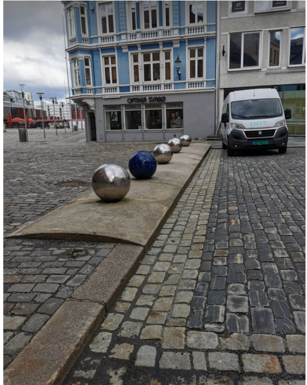
Figur 28 - Sluk nedover langs kantstein mot bunnen, hvor det er satt opp en "voll" for å fordrøye noe av overvannsmengdene. Og hindre mengdene i å renne over og ned i Vågsallmenningen, for heller å renne ned i sluk og inn i anlegget, privat
