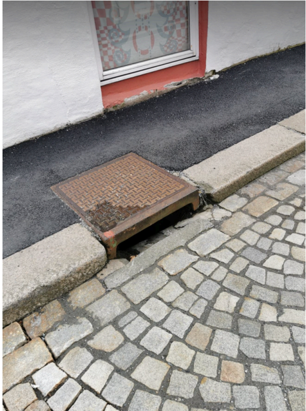
Figur 5 - Lille Øvregaten, Oppstrøms for oppgavens geografiske avgrensning, med sluk som tilsynelatende er koblet på avløp-fellesledningen gjennom området, privat
