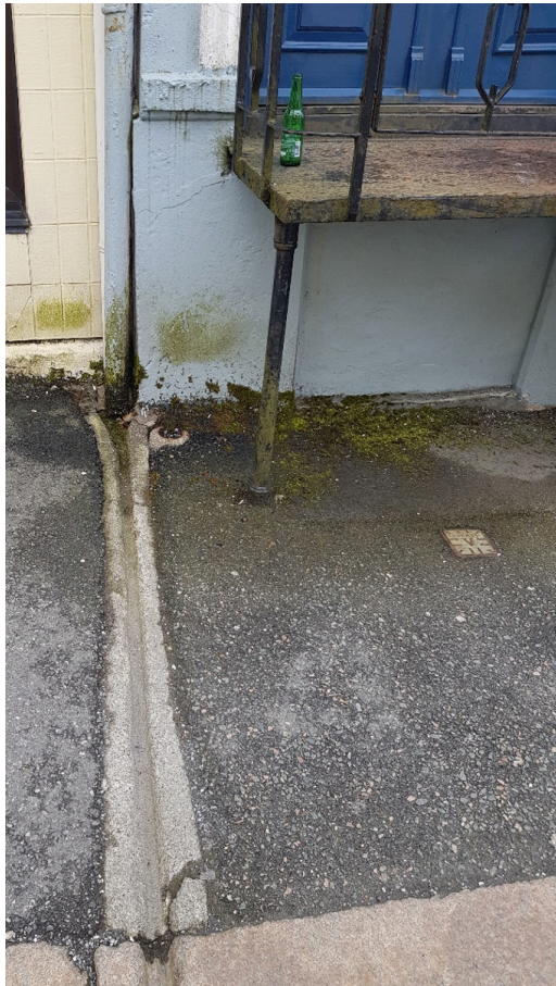
Figur 20 - Taknedløp med utspylere ut over kantsteinen, privat
