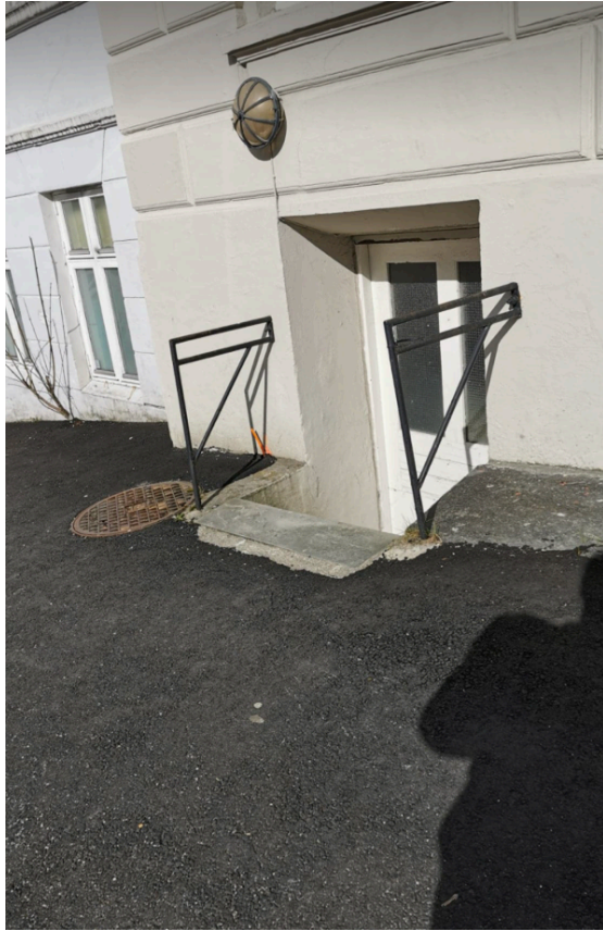
Figur 11 - Nedgang til kjellere, begge stedene er det "bygd opp" asfaltkant for å lede bort overvannet fra trappegangen, privat
