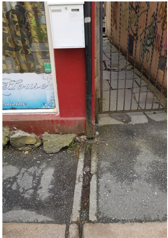
Figur 18 - Frakoblede taknedløp med tette utspylere ned og ut over kantsteinen, privat
