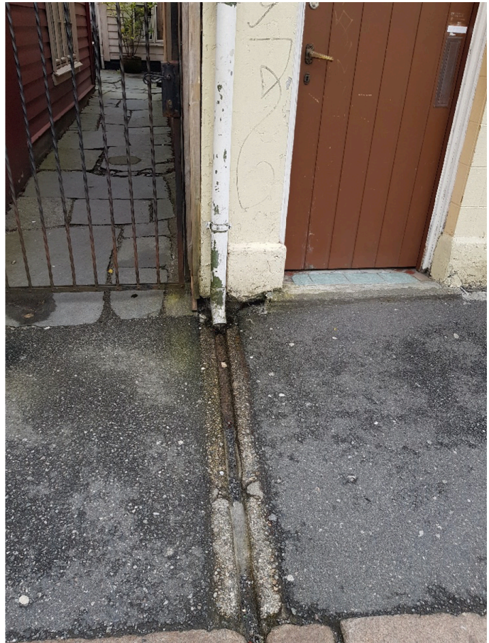
Figur 19 - Frakoblede taknedløp i dårlig forfatning med tette utspylere ut til kantsteinen, privat
