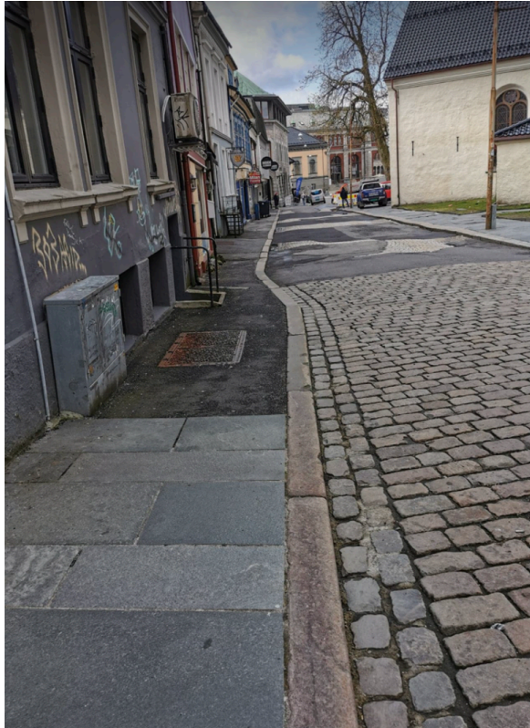
Figur 17 - Slitt og dårlig dekke som viser store tegn til setninger, og ingen sluk før i bunnen ved infiltrasjonsanlegget, privat
