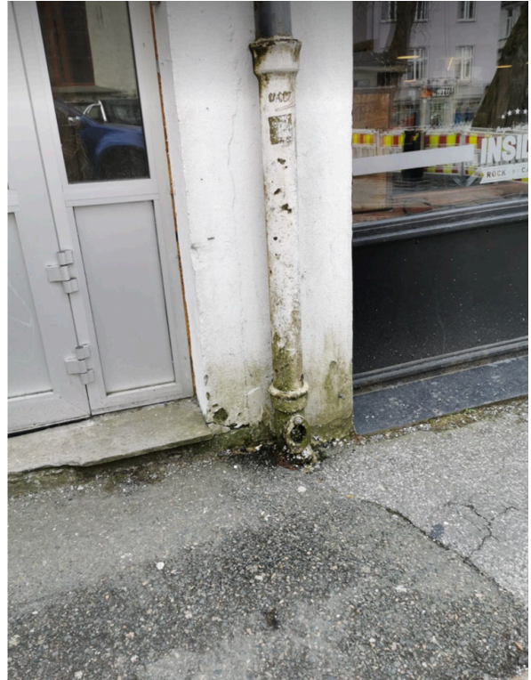
Figur 21 - Kjellernedgang med tegn til fukt (høyre). Taknedløp tilkoblet avløp-fellesledningen (venstre), privat
