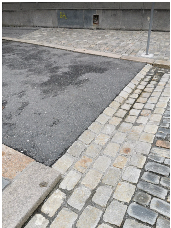
Figur 28 - Sluk nedover langs kantstein mot bunnen, hvor det er satt opp en "voll" for å fordrøye noe av overvannsmengdene. Og hindre mengdene i å renne over og ned i Vågsallmenningen, for heller å renne ned i sluk og inn i anlegget, privat
