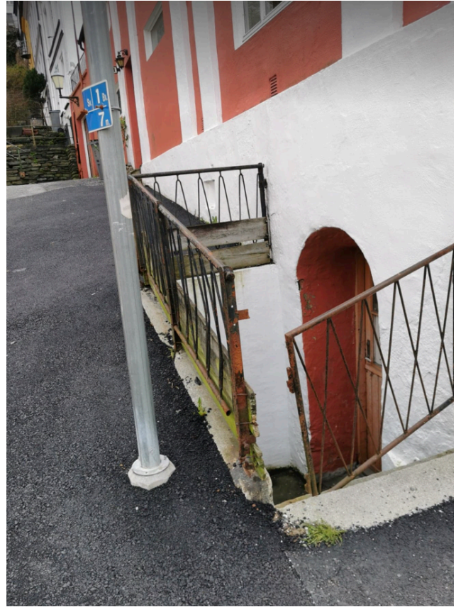
Figur 11 - Nedgang til kjellere, begge stedene er det "bygd opp" asfaltkant for å lede bort overvannet fra trappegangen, privat
