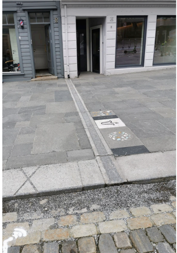
Figur 26 - Alt takvann fra omkringliggende bygg føres på samme måte ut over gangarealet og ut i veiflaten, hvor det renner til nærmeste sluk og ned i infiltrasjonsanlegget, privat
