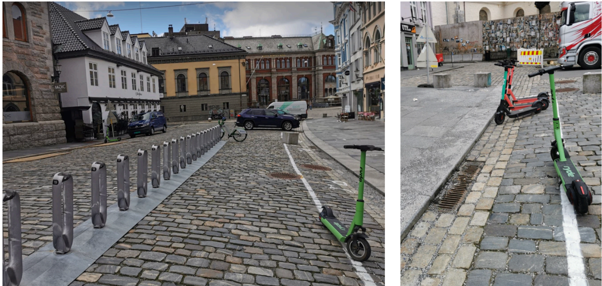
Figur 25 - Infiltrasjonsanlegget, ferdigstilt i 2018. Består av en brosteinslagt overflate med fall ned på alle sider til ristsluk, hvor vannet føres inn i sandfang og videre inn i infiltrasjonsanlegget/laksetrappen, privat
