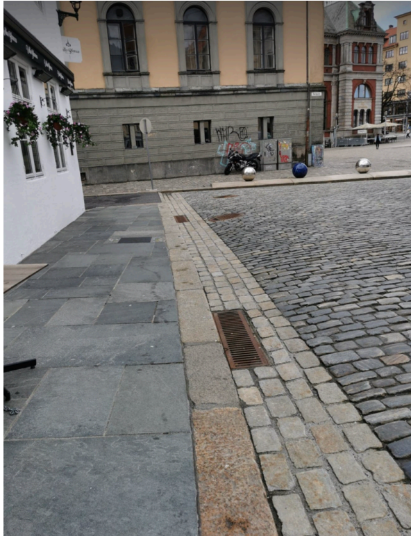
Figur 28 - Sluk nedover langs kantstein mot bunnen, hvor det er satt opp en "voll" for å fordrøye noe av overvannsmengdene. Og hindre mengdene i å renne over og ned i Vågsallmenningen, for heller å renne ned i sluk og inn i anlegget, privat
