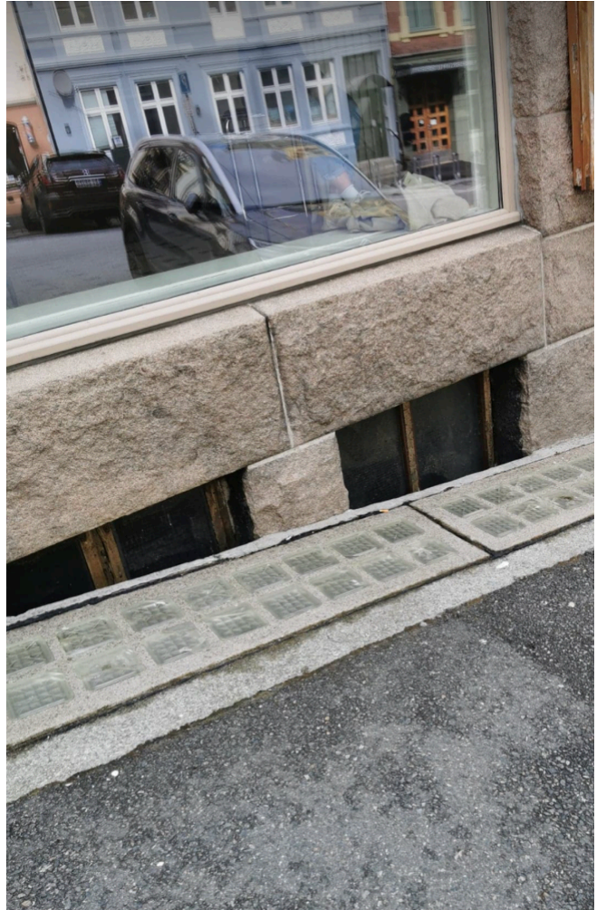
Figur 12 - Alternativ overvannsavledning foran vinduene som tydelig bærer preg av fukt og råte, privat
