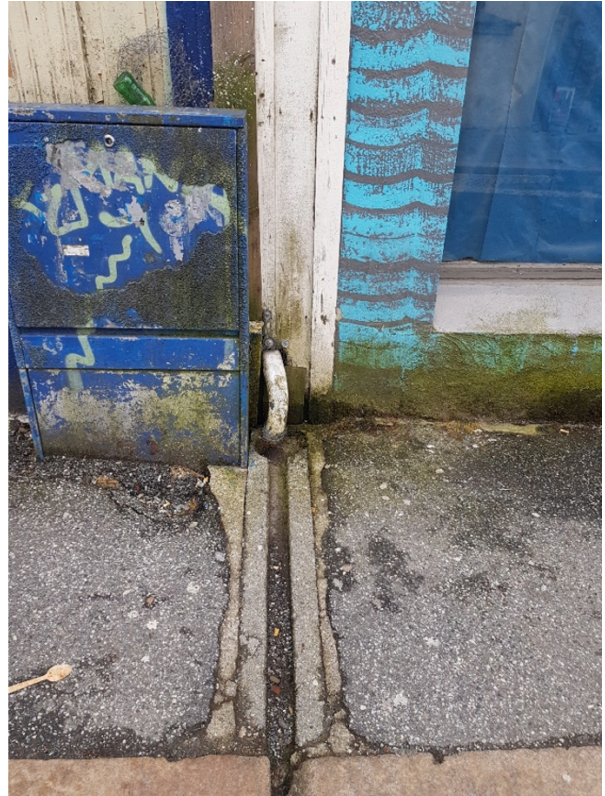
Figur 19 - Frakoblede taknedløp i dårlig forfatning med tette utspylere ut til kantsteinen, privat
