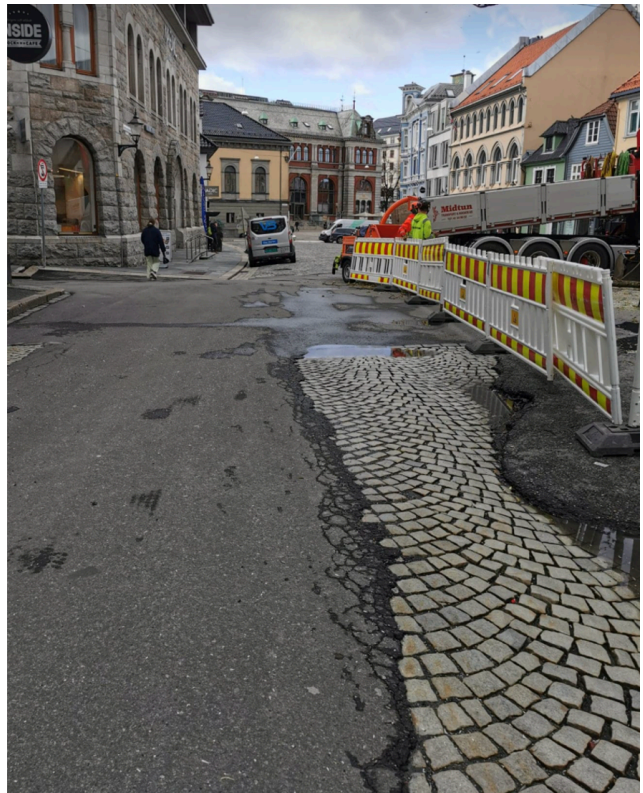
Figur 22 - Slitt og dårlig dekke hvor det har tendens til å samle seg vann, privat
