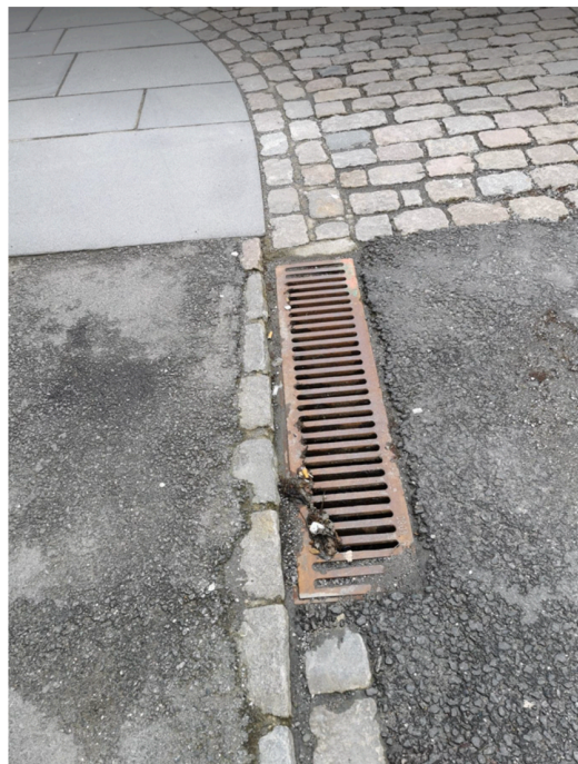
Figur 13 - Ristsluk på hver side av Øvre Korskirkeallmenningen oppstrøms for kryssningen ved Kong Oscars gate, privat
