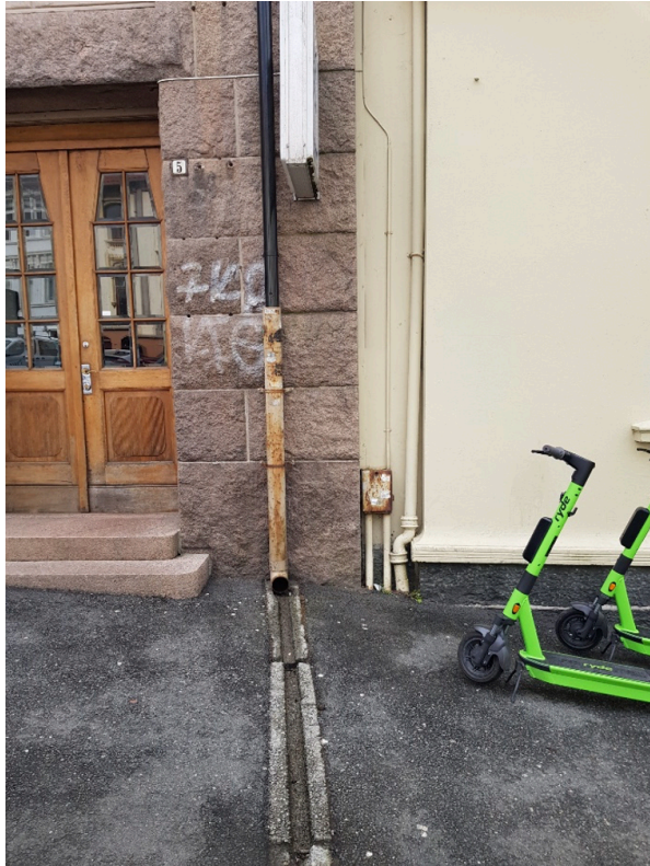
Figur 9 – Tilkoblede og frakoblede taknedløp, privat
