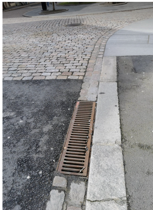
Figur 13 - Ristsluk på hver side av Øvre Korskirkeallmenningen oppstrøms for kryssningen ved Kong Oscars gate, privat
