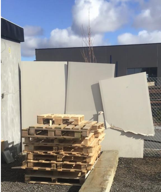
Figur 9 Fullskalaforsøk - Gipsplater montert på nettinggjerdet
