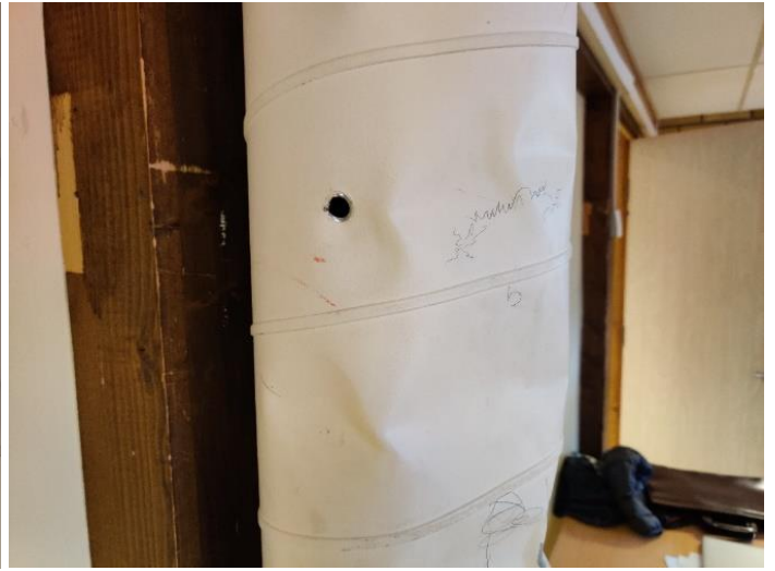
Figur 314 Ventilasjonsrør, hærverk
