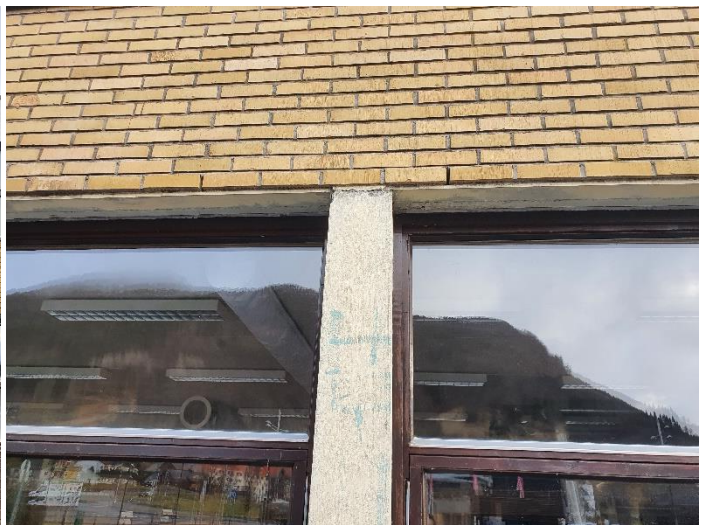
Figur 110 Berande betongsøyle riss og avflassing, plan 0
