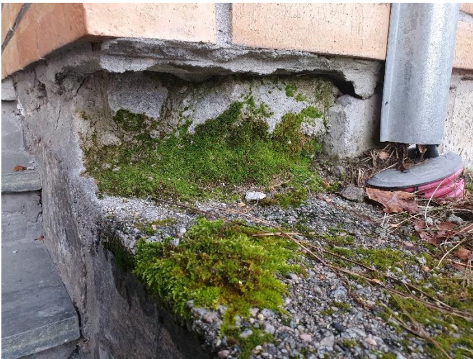
Figur 503 Fundamentskade
