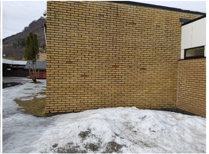
Figur 202 Teglstein frostsprenging
