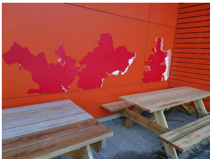
Figur 418 Avflassa maling på fasadeplate
