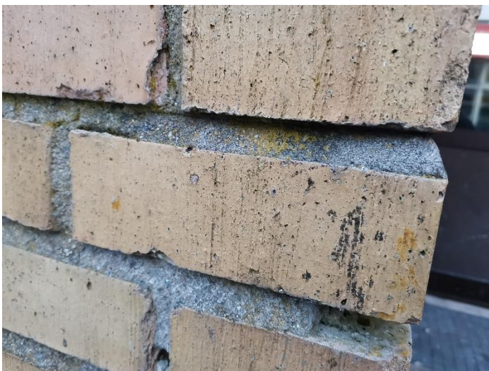
Figur 305 Teglstein soppvekst
