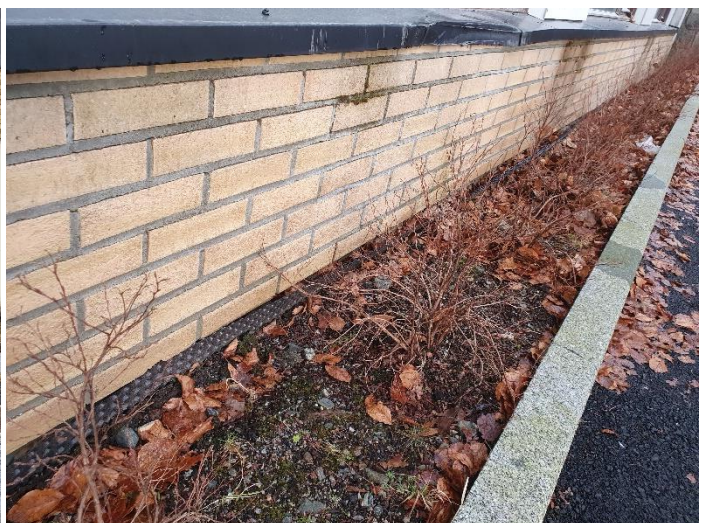
Figur 112 Knotteplast rundt ringmur, plan 0
