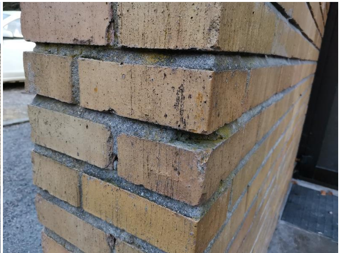
Figur 304 Teglstein soppvekst
