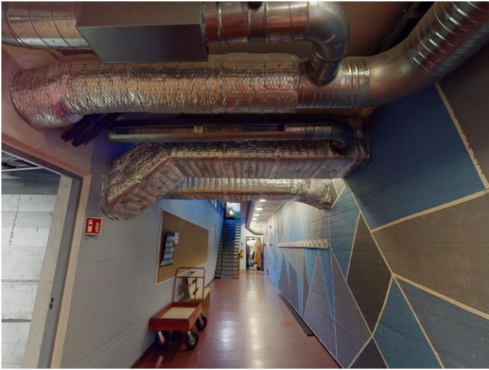
Figur 137 Synleg ventilasjonskanal
