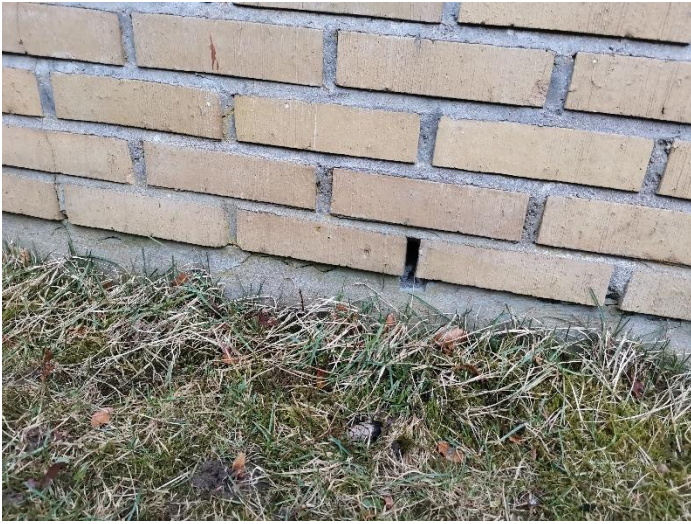
Figur 307 Fundament setningskade
