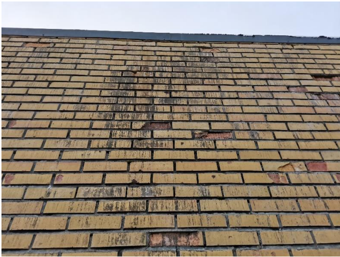
Figur 301 Teglstein frostsprenging
