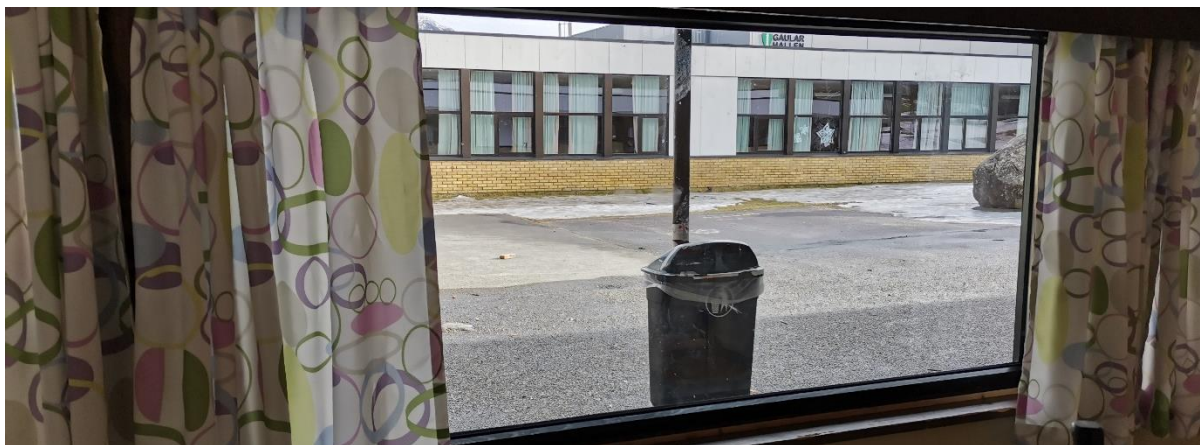
Figur 6 - 6: Gamalt vindauge som ikkje er eigna for ombruk
