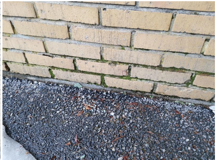
Figur 204 Teglstein mosevekst
