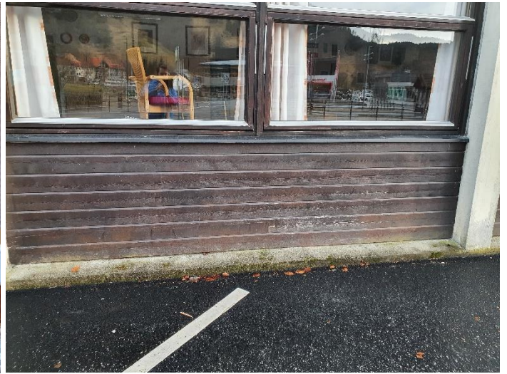
Figur 140 Ikkje berande yttervegg av tre
