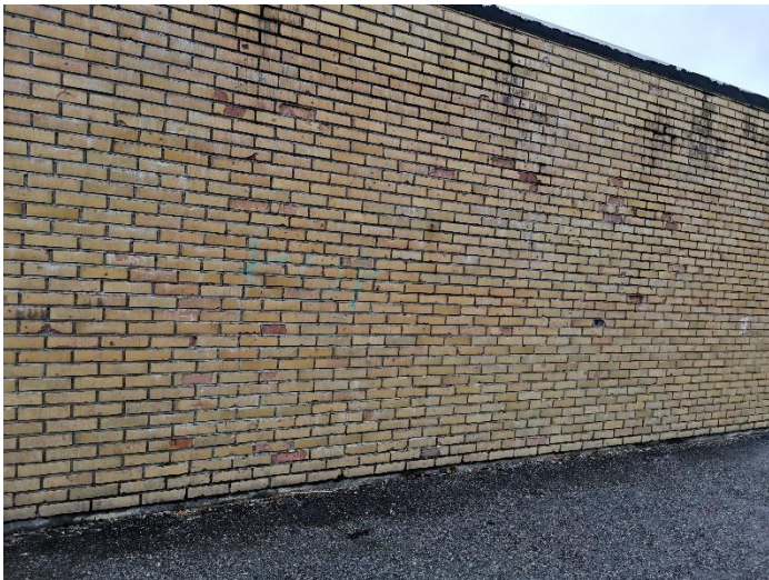
Figur 303 Teglstein frostsprenging
