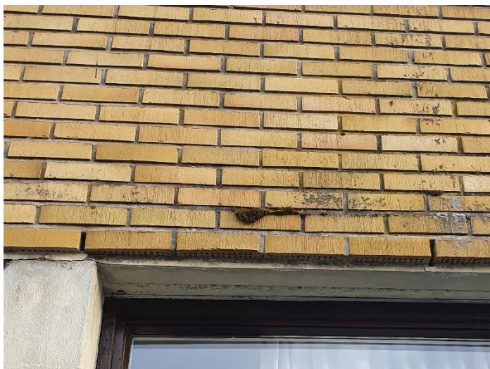
Figur 125 Mosevekst på yttervegg plan 1
