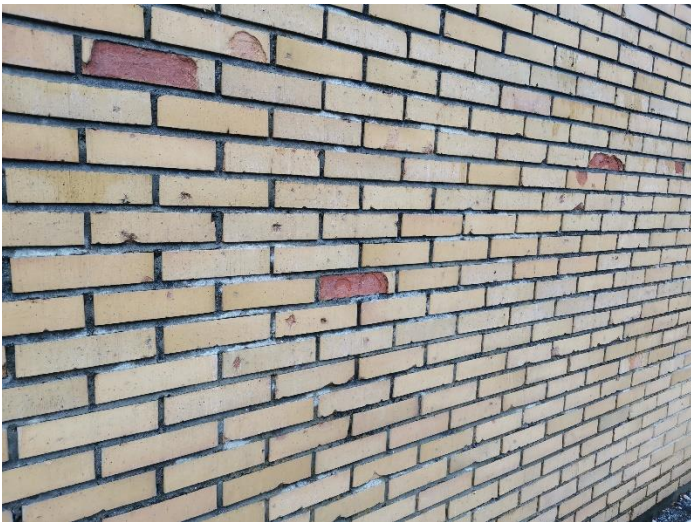
Figur 203 Teglstein frostsprenging
