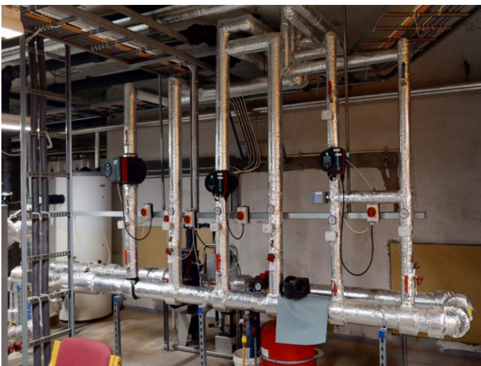
Figur 405 Røyrssystem til vassboren varme i bassengkjellar, plan 0
