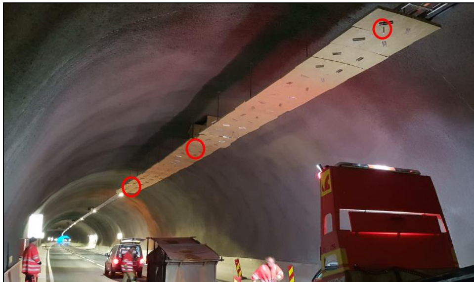
Figur 34 - Temperaturmålepunkter markert med røde sirkler ved brannøvelse i Mælefjelltunnelen
