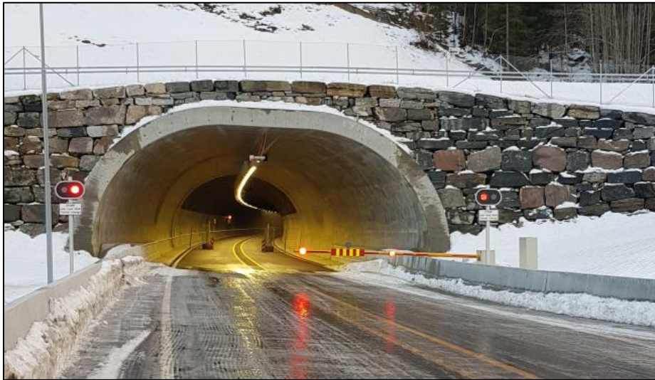
Figur 35 - Tunnelportal mot Notodden ved oppstart av brannøvelsen
