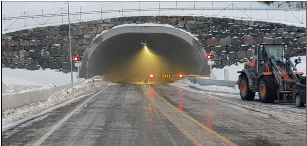
Figur 68 - Brannrøyken ankommer Notodden tunnelportal ca. 30 minutter etter brannantennelse
