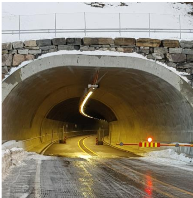
Figur 70 - Bilde av tunnelportal mot Notodden som viser at tunnelportalen er røykfri etter snudd ventilasjonsretning. Bilde er tatt 65 minutter etter brannantennelsen
