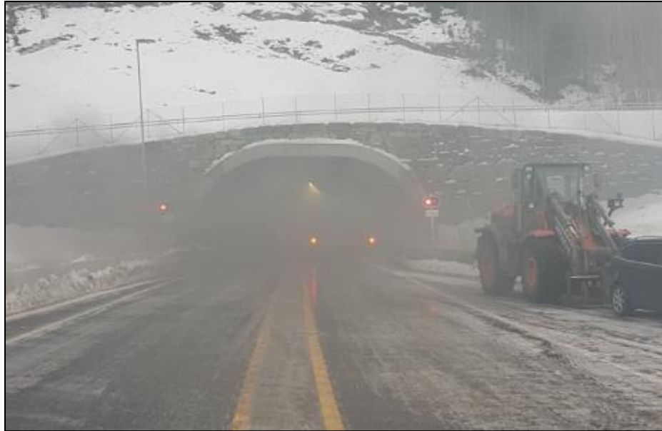
Figur 69 - Brannrøyk som ankommer tunnelportal Notodden etter 40 minutters brannforløp
