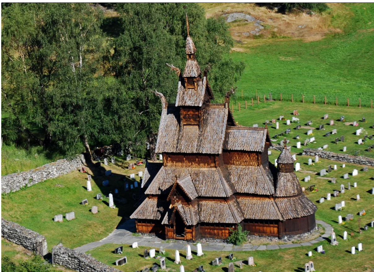
Figur 45. Borgund stavkyrkje frå ca 1180 er nok den eldste og mest spesielle bygningen i Lærdal.
