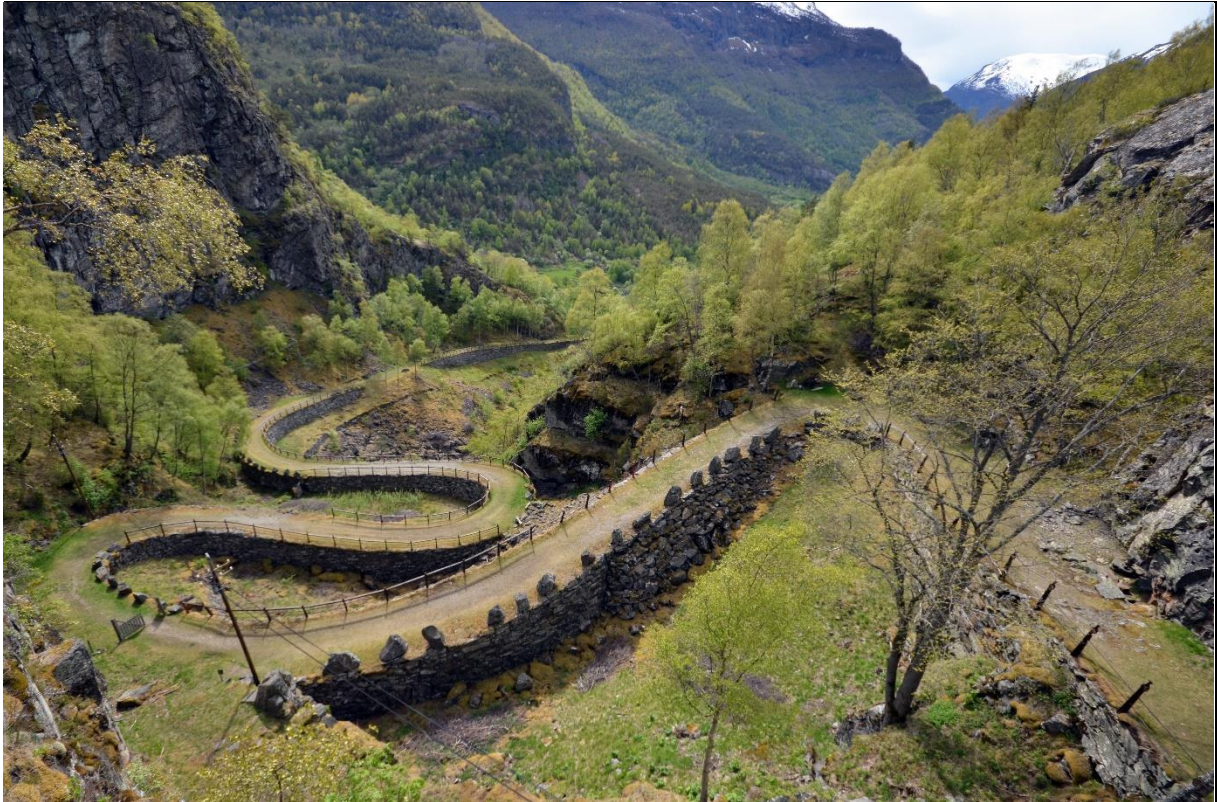
Figur 36. Den eldste vegen gjennom Vindhellaskaret hadde ei stigning på 1:4. Over den gamle og bratte vegen vart det i 1843 ferdigstillt ein ny veg i store slynger med stigning på 1:5.
