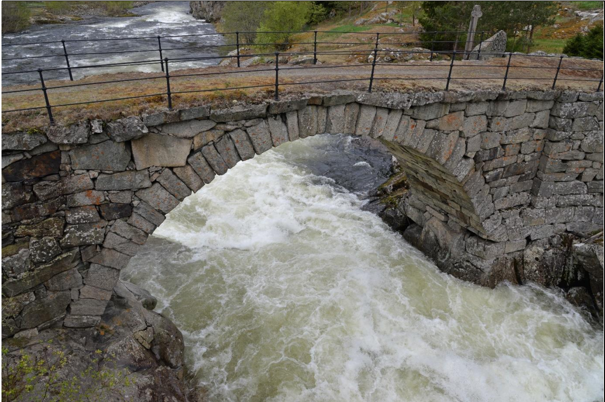
Figur 42. Kvelvingsbrui ved Nedre Kvamme er ein del av veganlegget frå 1870-åra.
