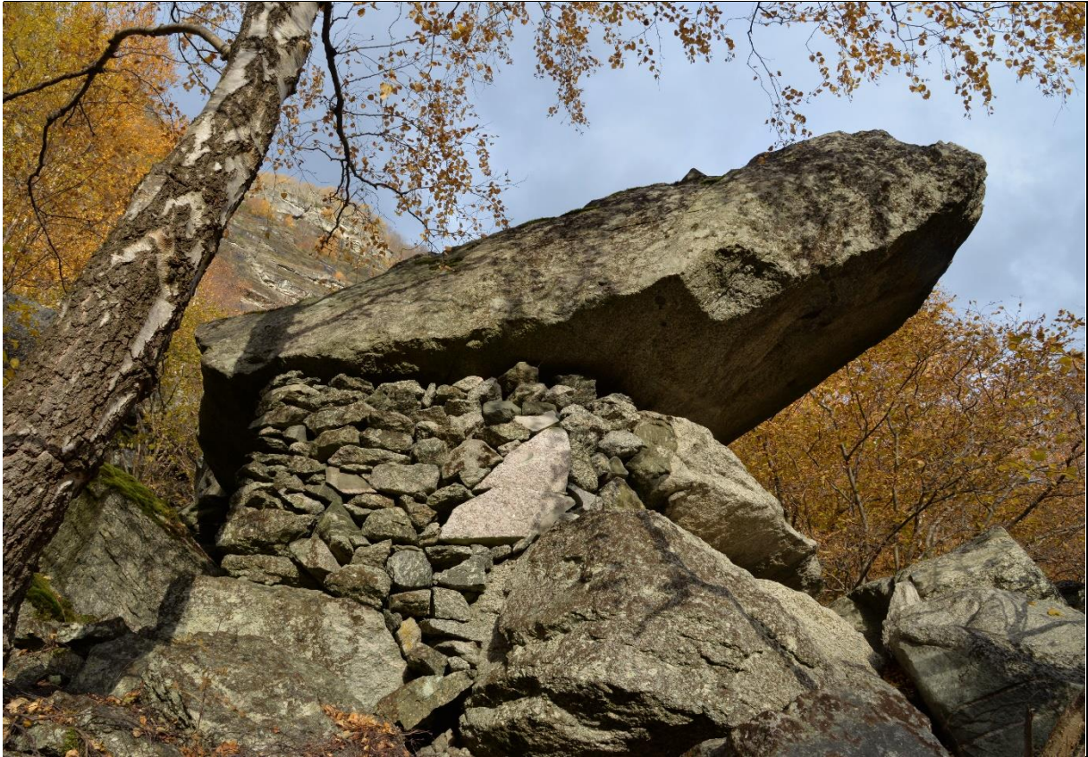
Figur 38. Underbygd steinblokk på Ljøsne for lagring av vinterfôr, helst lauv.
