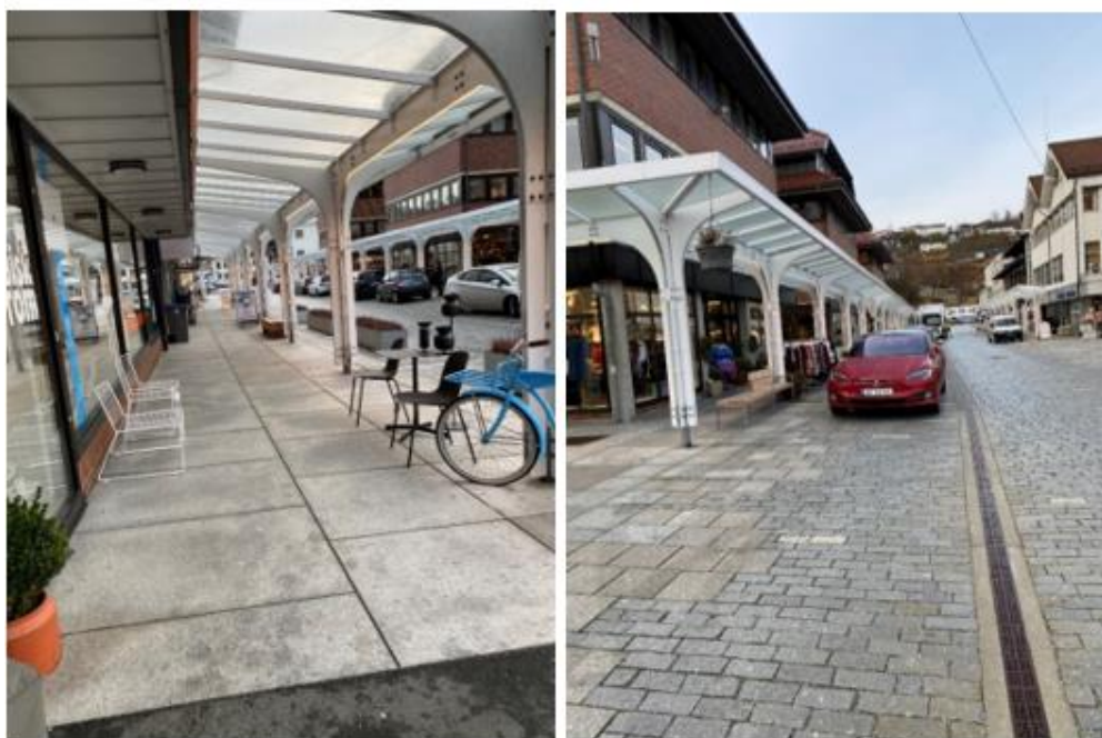
Figur 31. Bilder av taket i handlegaten (Bilder tatt av oss, 2020).
