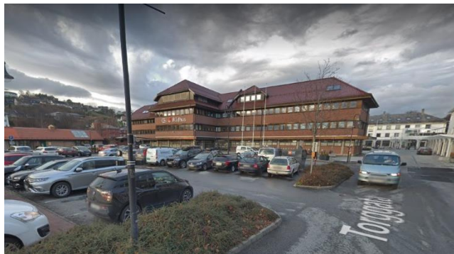
Figur 77. Kommunehuset på Osøyro (Google Maps, 2018).
