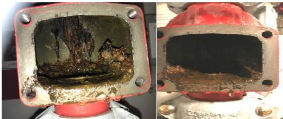
Figur 2. Bilde av to ventiler i sprinkleranlegget, der man ser rester av sedimentene som lå i store mengder i hver ventil.
