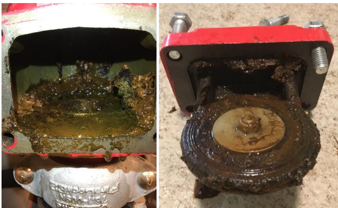
Figur 19 – Bildet til venstre er av innsiden av tilbakeslagsventil på glykolsløyfe. Bildet til høyre er av tilhørende ventilkloff
