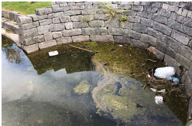
Figur 87: Sjøppel blir liggende. Mindre trær vokser fra muren. På sikt vil disse trærne bryte opp og ødelegge muren, dersom de ikke fjernes.
