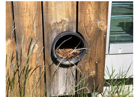
Figur 86: Utløpene for takrennene på laksesenteret viser tydelig mangel på vedlikehold.
