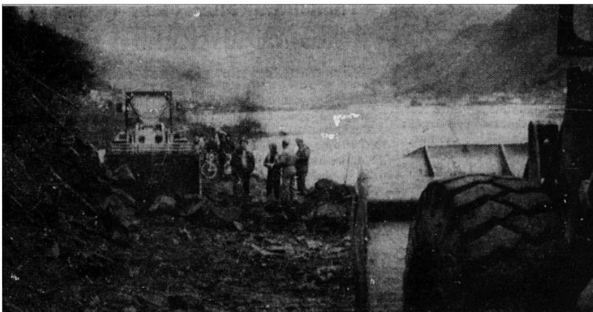
Figur 14: Arbeid med å rydde vegen etter eit at det gjekk eit stort steinsprang 25. desember 1977, om lag 200 m vest for opninga av dagens tunnel. Foto henta frå Sogningen-Sogns Avis (1977).
