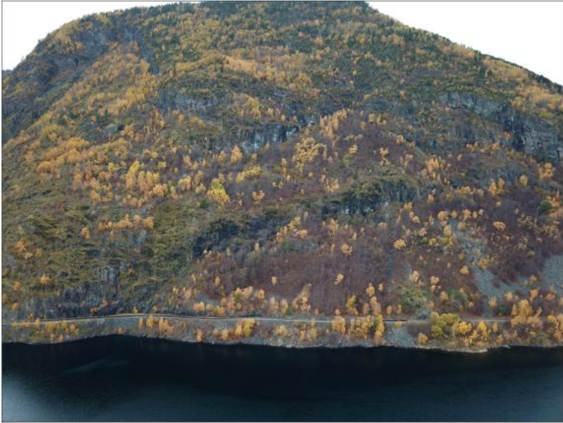
Figur 8: Bratte skrentar og steinur i overkant av vegen. Dronefoto, 17.10.2019. Dette fotoet viser området innanfor ramma i figur 7.
