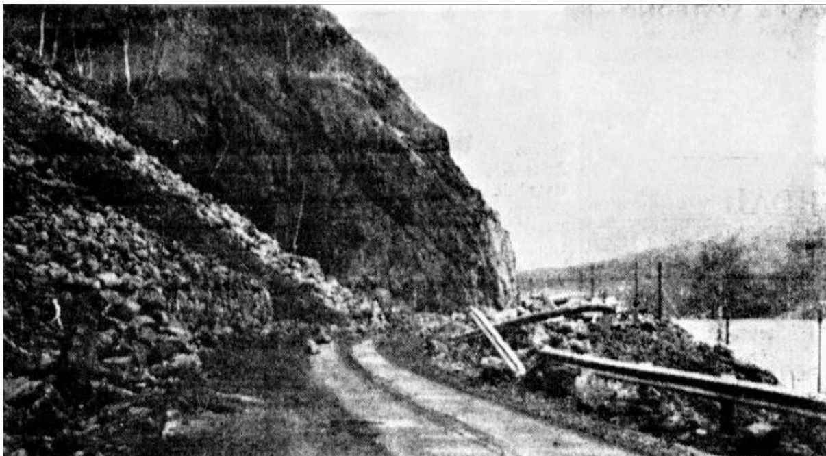
Figur 13: Vegen ved Rubbeskallen etter eit stort steinsprang i 1972. Dette er to år før skredoverbygget vart bygd. Foto frå Sogningen-Sogns Avis (1972).
