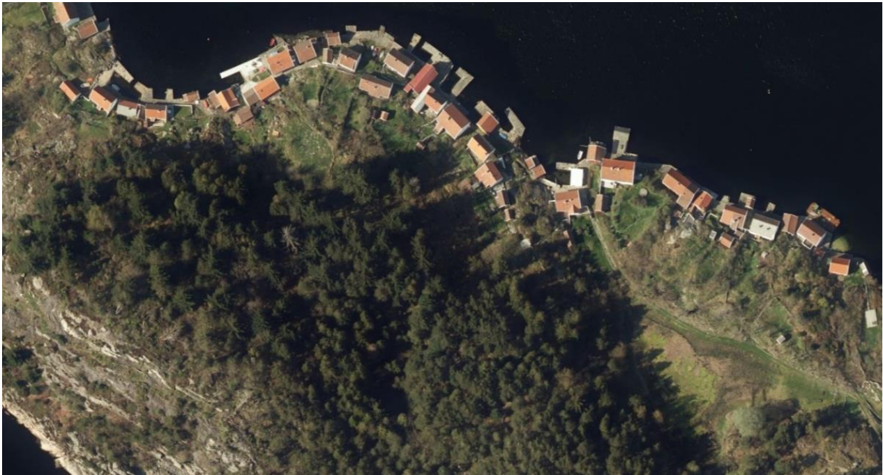
Figur 57: Flyfoto av tett trehusbebyggelse på Svinør som ligger tett inntil vegetasjonen.
