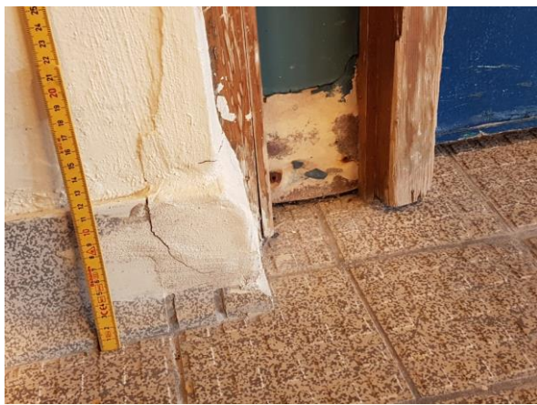
Bilde nr. 1.51 Sprekk i sokkelflis innvendig skillevegg. Fuktskader i form av malingsavflassing og grånende trevirke i dør.
