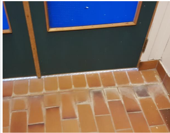
Bilde nr. 1.52 Kalkavsetning og tilsmussing av fuger og fliser.
