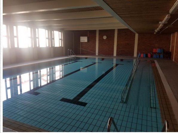
Bilde nr. 1.20 Svømmehall. Bilde er tatt mot yttervegg tilhørende fasade nordvest.
