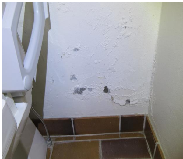
Bilde nr. 1.58 Blemmer og malingsavflassing i malingsfilm ved WC i skillevegg inn mot dusjanlegg.
