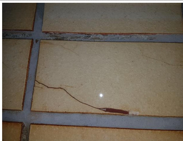
Bilde nr. 1.28 Brudd i keramisk flis
