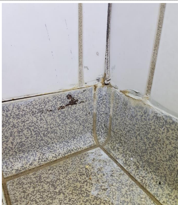
Bilde nr. 1.55 Soppangrep på silikofuge i hjørne i dusjanlegg. Fugen har løsnet i nedre del. Utett overgang mellom sokkelflis og flis.
