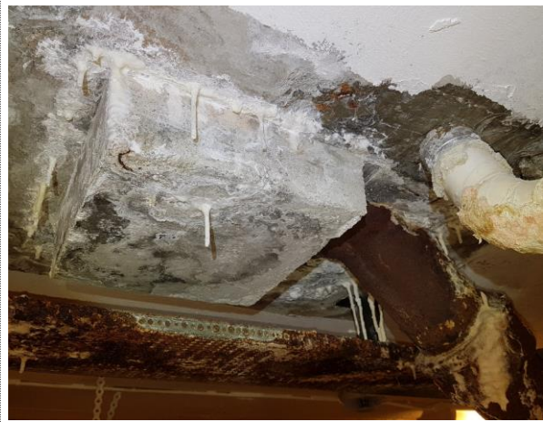
Bilde nr. 1.86 Kalkutfellinger og stalaktitter rundt sluk fra dusjanlegg
