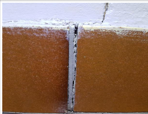
Bilde nr. 1.52 Kalkavsetning og tilsmussing av fuger og fliser.
