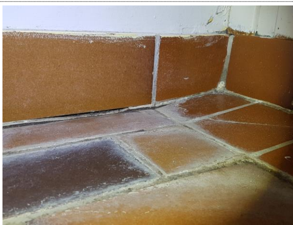
Bilde nr. 1.51 Sprekk i sokkelflis innvendig skillevegg. Fuktskader i form av malingsavflassing og grånende trevirke i dør.
