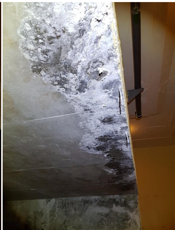
Bilde nr. 1.70 Stalaktitt i underkant av bassengtrau
