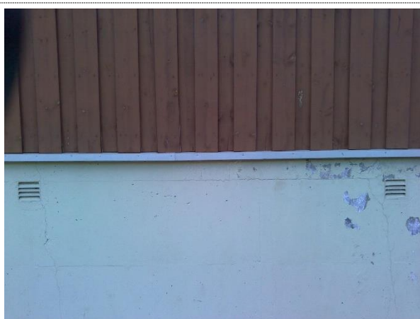
Bilde nr. 1.17 Termografert sørvest fasade.
