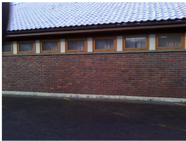
Bilde nr. 1.13 Termografert nordøstfasade
