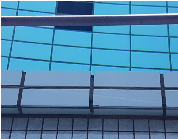
Bilde nr. 1.21 Tæring av fuger, ved rampe ned i basseng
