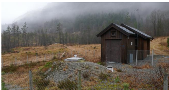
Figur 65: Inngjerding av brønnsone og forbud mot forurensing (foto: privat)
