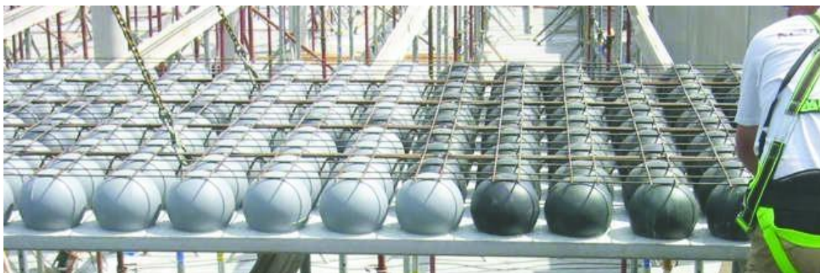
Figur 6.37: Prefabrikkert plateelement, Bubbledeck, som sammen med betongpåstøp blir et dekke [30]
