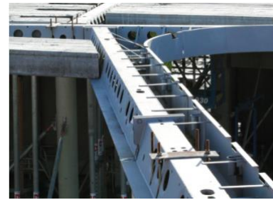
Figur 6.6: Spesialtilpasset sidesteng gir mulighet for formet hjørne [23]
