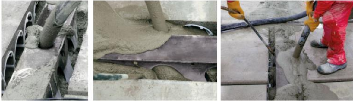
Figur 7: Utstøping av Deltabjelke (Peikko, 2015, p. 29)
