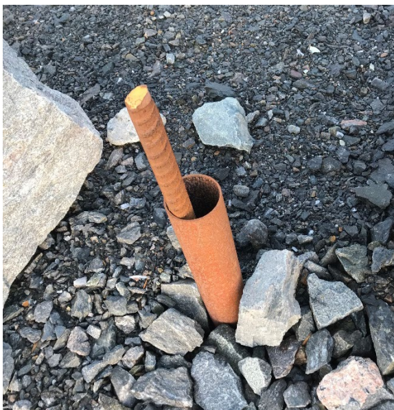
Figur 28 – Setningsbolt før fjerning av forbelastningen. Eget foto.
