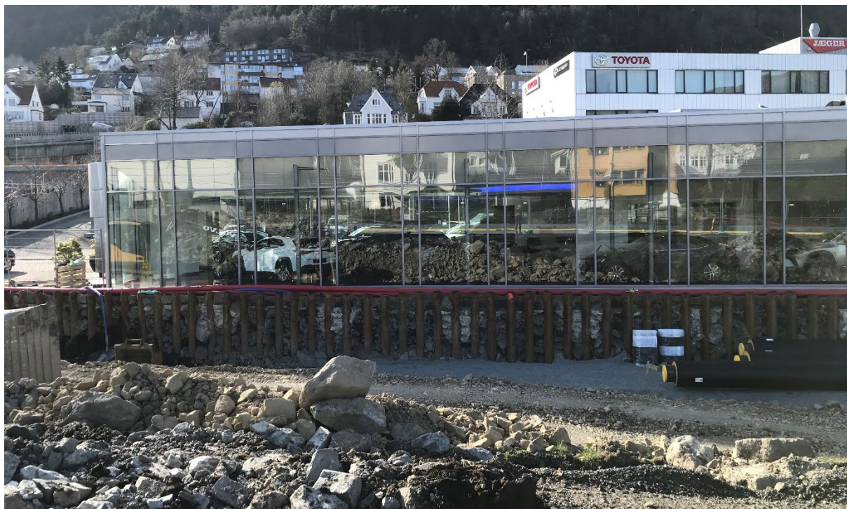
Figur 32 – Masseutskiftning ved Jæger langs Kanalveien. Eget foto.
