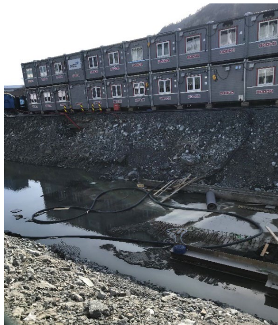
Figur 31 – Byggegrøp for kulvert langs banetraséen. Eget foto.
