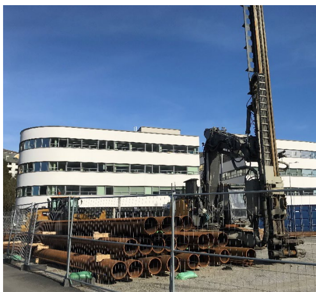
Figur 10 – Foringsrør til stålkjernepeler ved Minde Allé. Eget foto.
