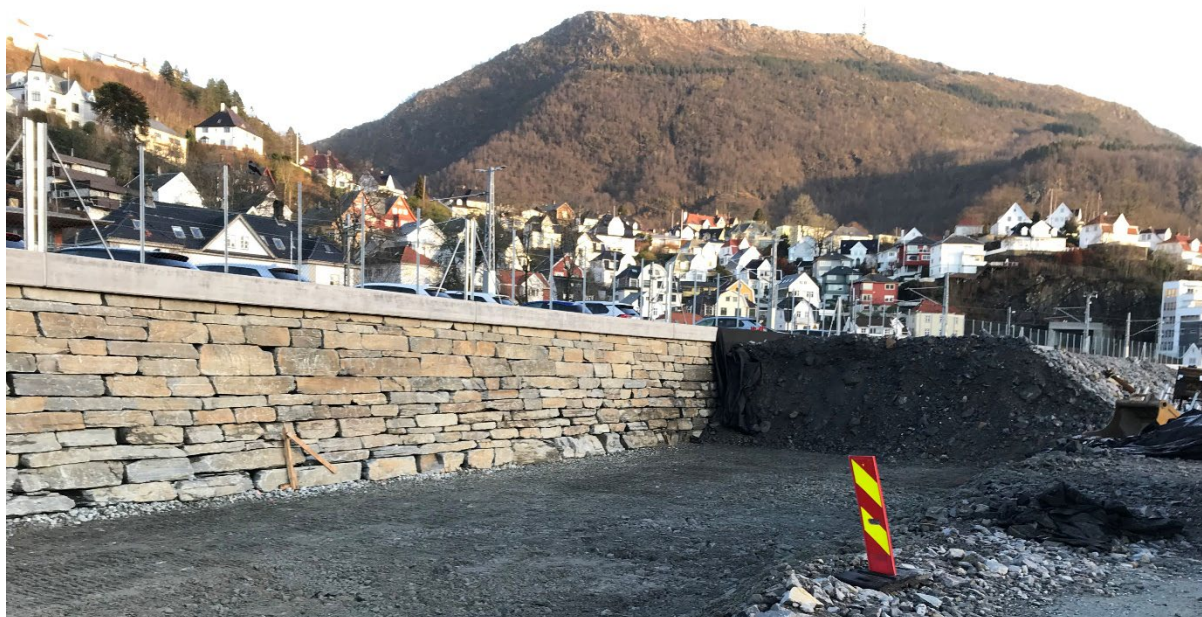
Figur 27 – Bilde av fjernet forbelastning langs Store Lungegårdsvannet. Eget foto.
