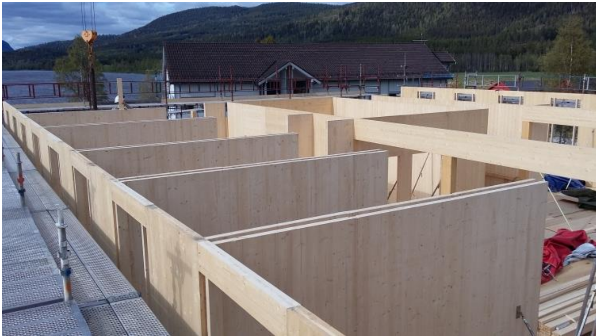
Figur 8: En oversikt over byggemetoden Massivtreelementer. Hentet fra hunton.no
