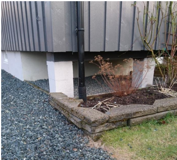
Figur 4: Taknedløp fra enebolig ned i bakken
