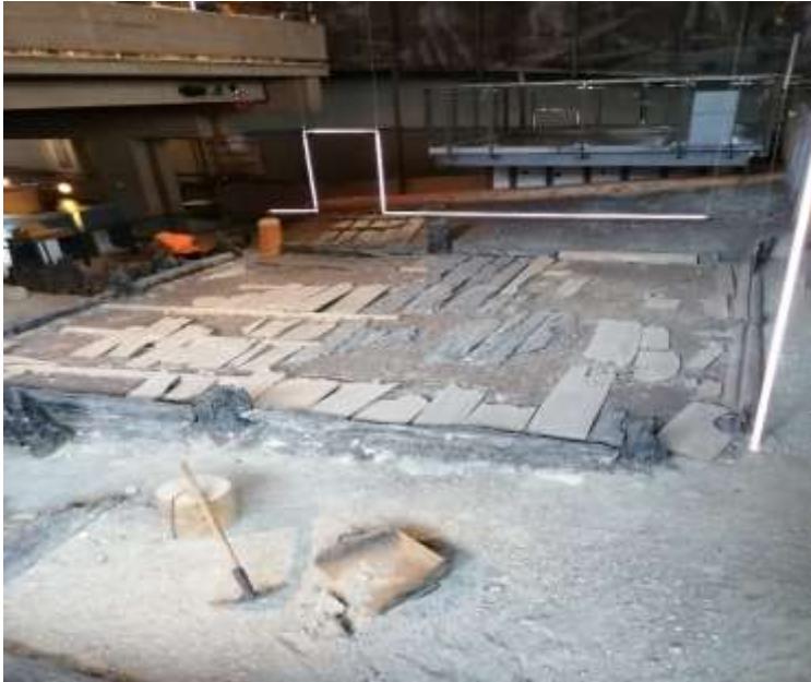
Bilete 1: Dei eldste grunnmurane til bygningane på Bryggen.
