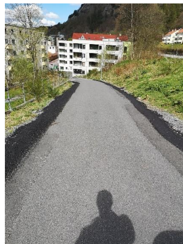
Figur 36: Asfalterte sidekanter i gangvei.
