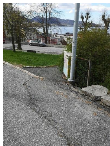
Figur 34: Inntak til kanal ved Uren.
