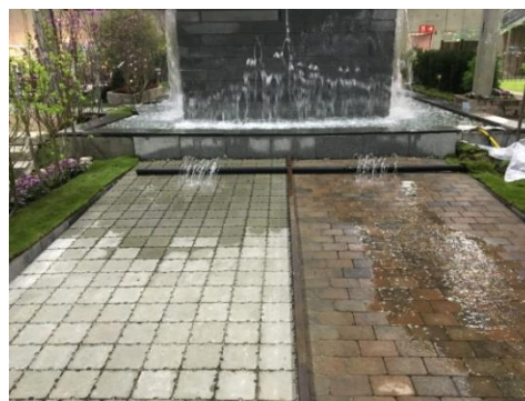
Figur 16: Permeabelt kontra tett dekke. Kilde: (Asak Miljøstein, 2020)
