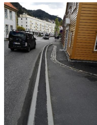
Figur 40: Opphøyet kantstein i Sandviksveien.
