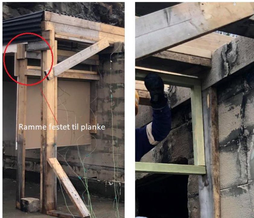
Bilde 7.3 – Festemetode for ramme i konstruksjonen
