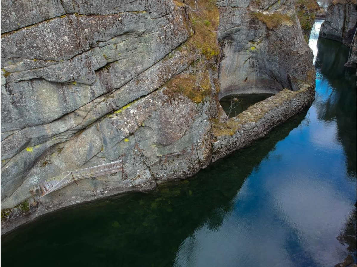
Figur 13: Bilde fra Soget viser restene av trekkveien med tre og fjellbolter til venstre og tørrmuren som forbygger jettegryten til høyre. Foto: Asbjørn Mong, 2019.
