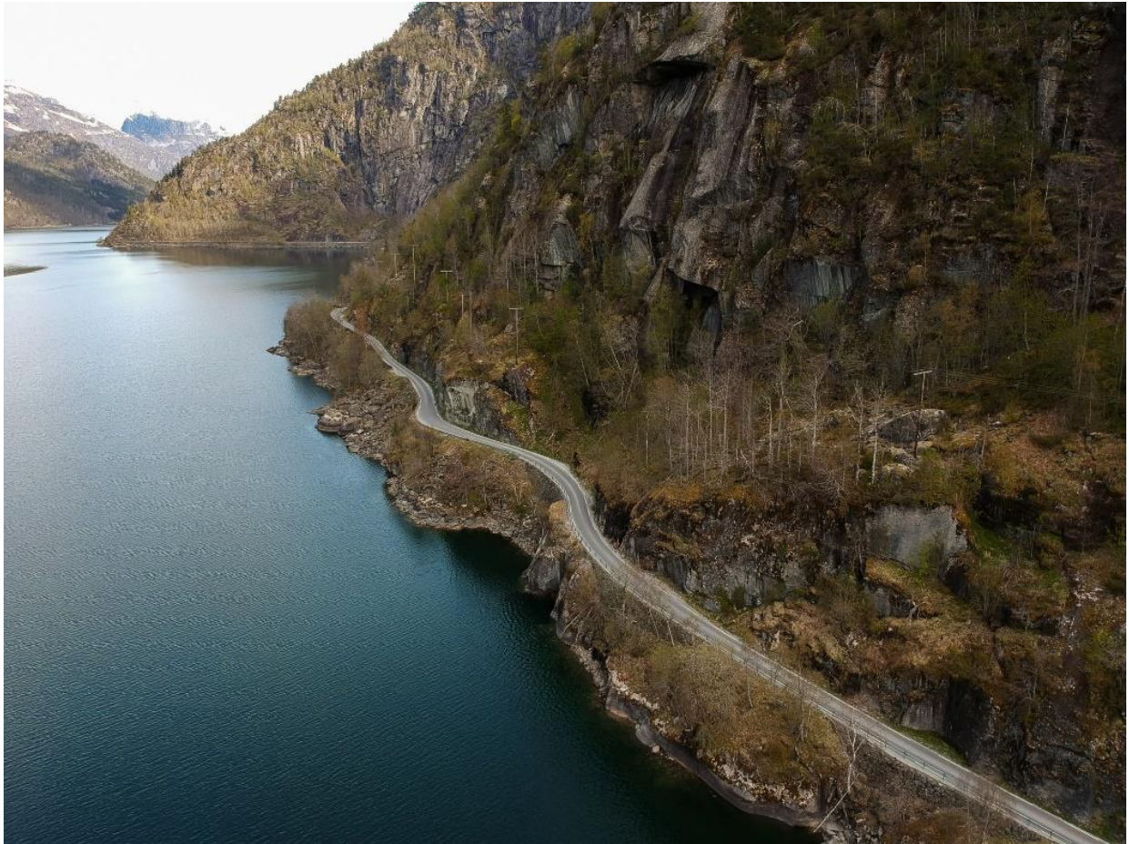
Figur 14: Bilde av en del av Veitastrondsvegen som går langs østsiden av Veitastronsvatnet. Foto: Asbjørn Mong, 2019.
