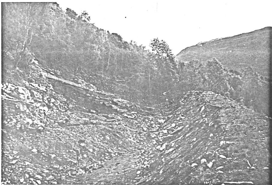
Foto nr. 2. Framstikkende fjellkravis i fanggravaes østre del reduserer vollhøgden og fanggravaes effekt.
