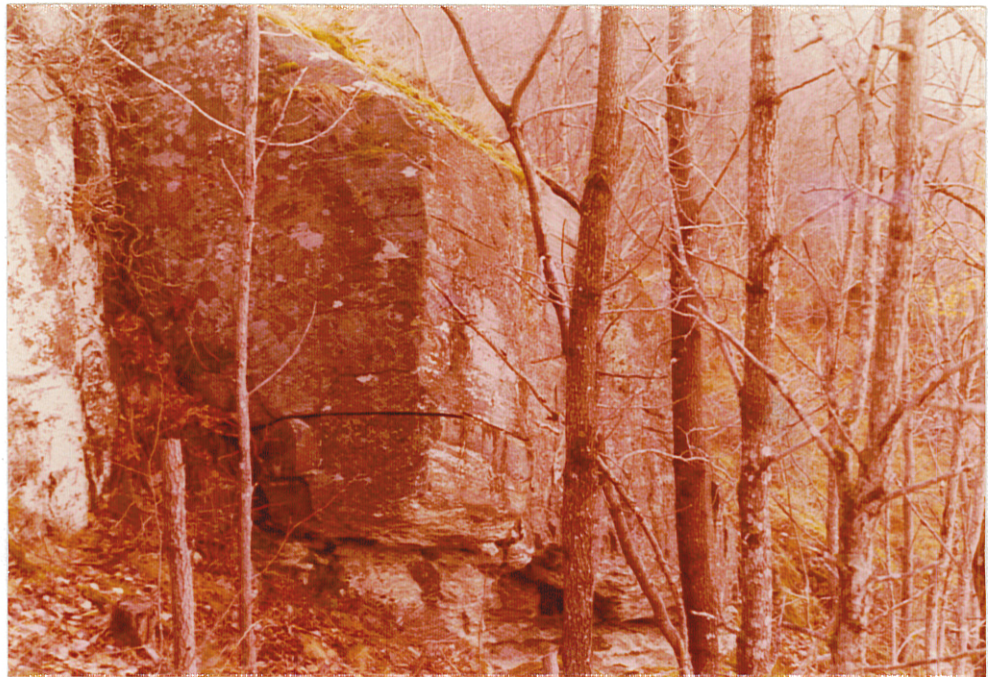
FOTO 2 RASFARLIG PARTI VED HAMMERNES VESTSIDE.
