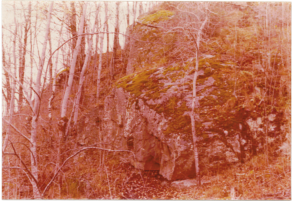
FOTO 1 RASFARLIG HAMMER VEST FOR SIKRINGSVOLLEN
