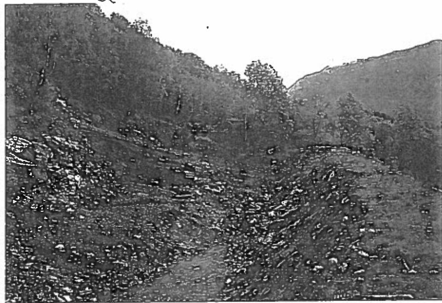
Foto nr.2. Framstikkende fjellknaus i fanggravens østre del reduserer vollhøyden og fanggravens effekt.
