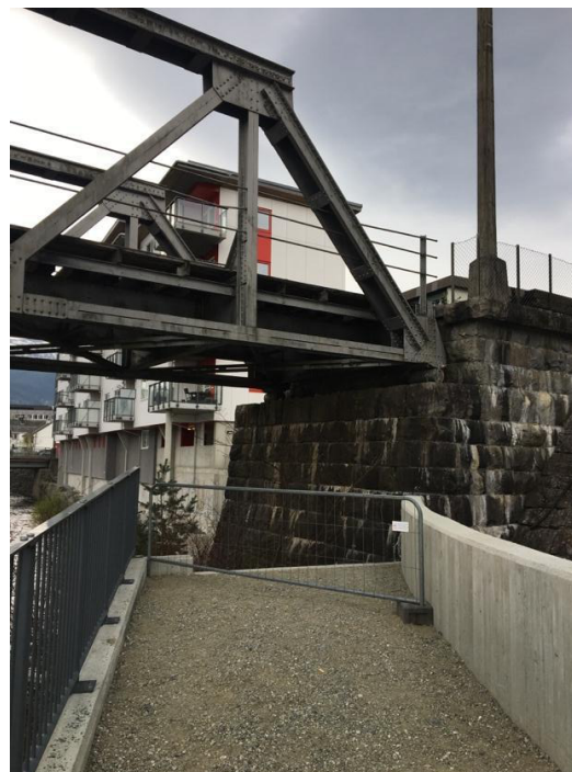
Figur 35: Gangveg ved Voss Elvegata
