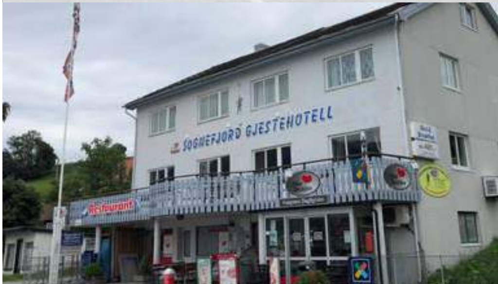
2. Næringsbygg - Sognefjord gjestehotell. Hotellet tilbyr overnatting, restaurant, souvenir handel og dagligvarehandel. Flere forskjellige skilt gir et uryddig og lite enhetlig totalinntrykk som går utover den visuelle opplevelsen man får av stedet.
