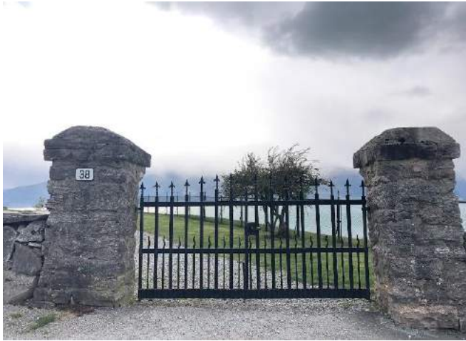
2. Port - Står i nordøstre del av parken og er i dag den eneste inngangen til parken.
