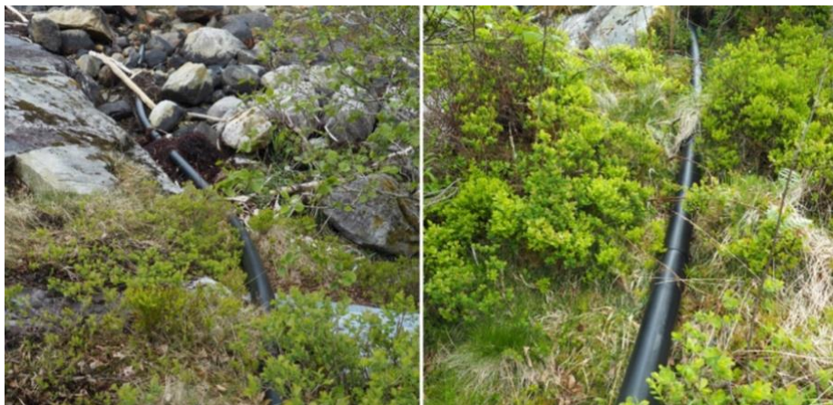
Figur 9: Det går nokre private avløpsrør langs steingarden og ut i fjorden omlag midt i planområdet.
