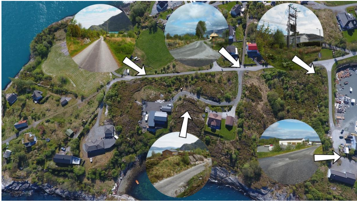
Figur 8: Kartet viser den eksisterande vegsituasjonen i planområdet, transformator og Skahjem bygg.
