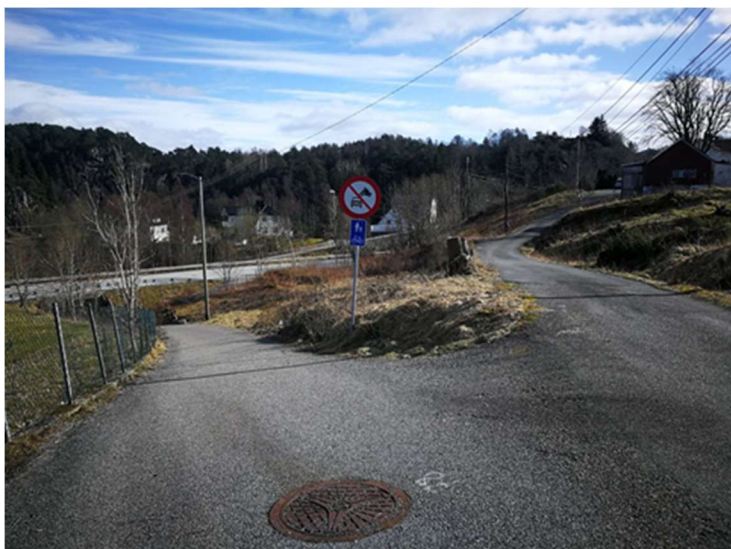
Figur 20: Gang- og sykkelveg ovenfor kulvert
