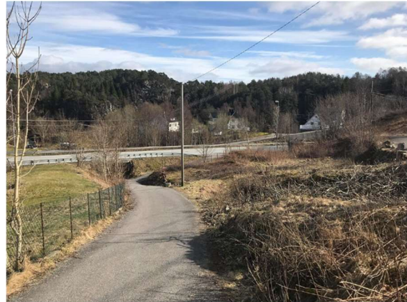
Figur 9: Bildet viser nedfart til eksisterende kulvert
