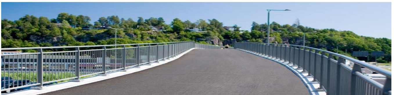
Bilde 33 – Foreslått rekkverk langs Lyderhornsveien. [115]
