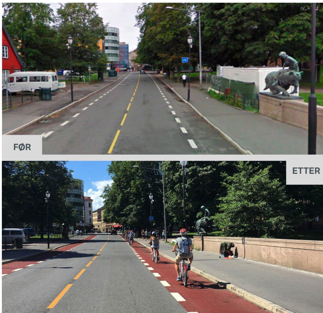
Bilde 5 - Sykkelfelt før og etter rødt dekke ble anlagt på Eventyrbrua i Oslo, bredden er uendret [40]
