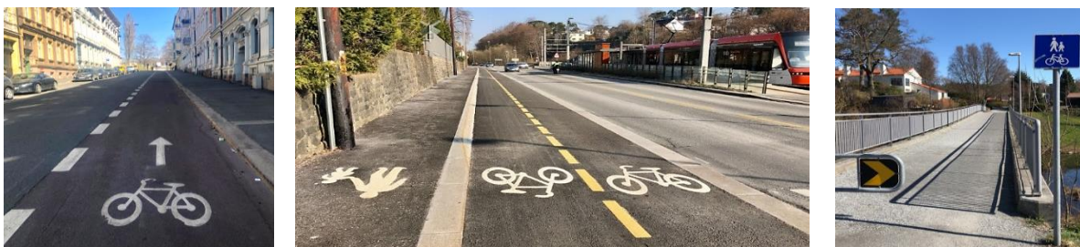
Bilde 3 - Eksempler på sykkelfelt, sykkelveg med fortau, og gang- og sykkelveg [Foto: Karine Johannessen, Margreta Instanes Jebran]
