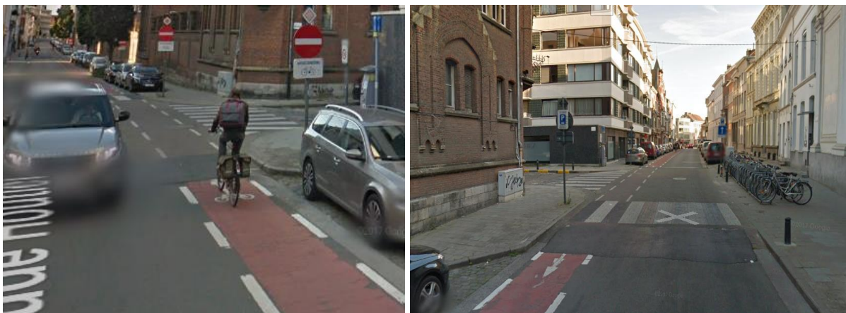
Bilde 13 - Inspirasjonsbilder fra Belgia, løsning med stipling gjennom kryss [Google Maps, Belgia [55]]
