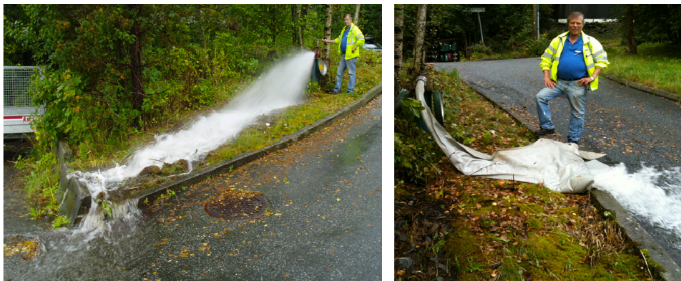
Figur 30: Fullt åpnet hydrant (illustrert på bilde til venstre) kan føre til skade på veg og vegetasjon. For å unngå dette brukes utjevningsduk, slange eller presenning (jf. bilde til høyre). Foto: Vanddistribusjon Bergen Vann kf, Terje Mellingen, 2017.
