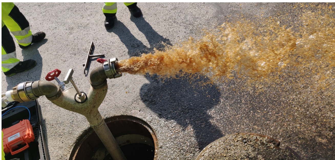
Figur 16: Eksempel fra gjennomføring av spyling. Foto: Kassem Ali Al-Sheikh
