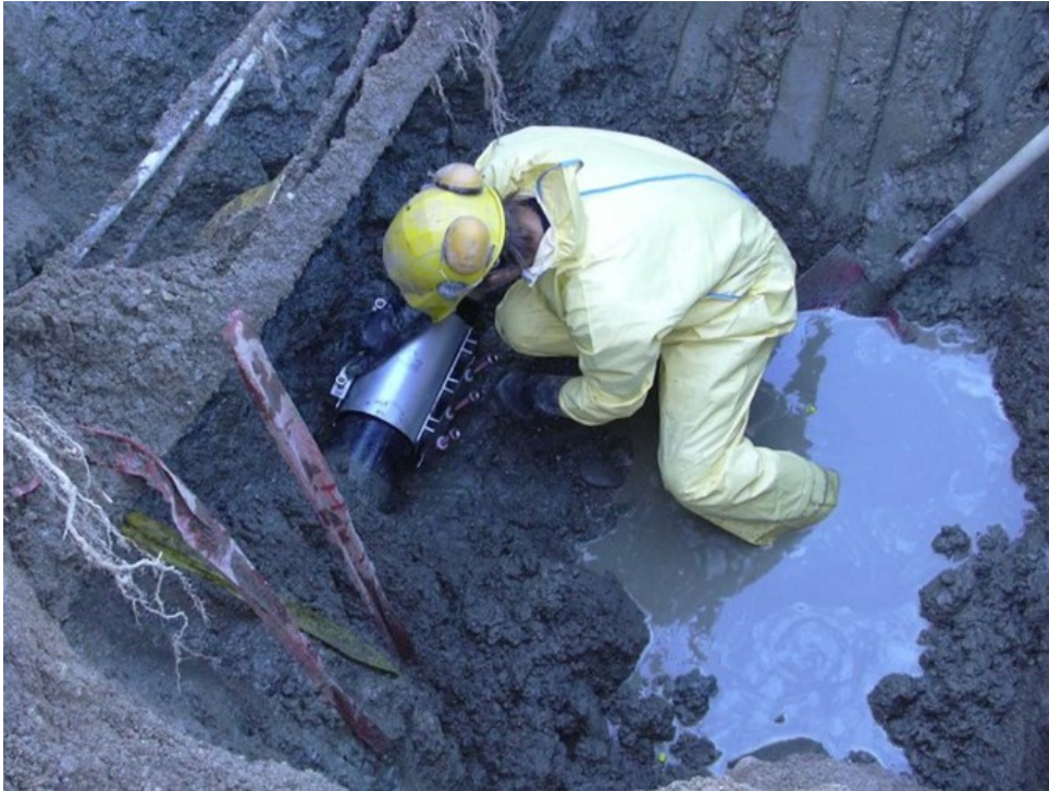
Figur 13: Bildet av reparasjonsarbeid ved et ledningsbrudd. Foto: Hans Hatmyr
