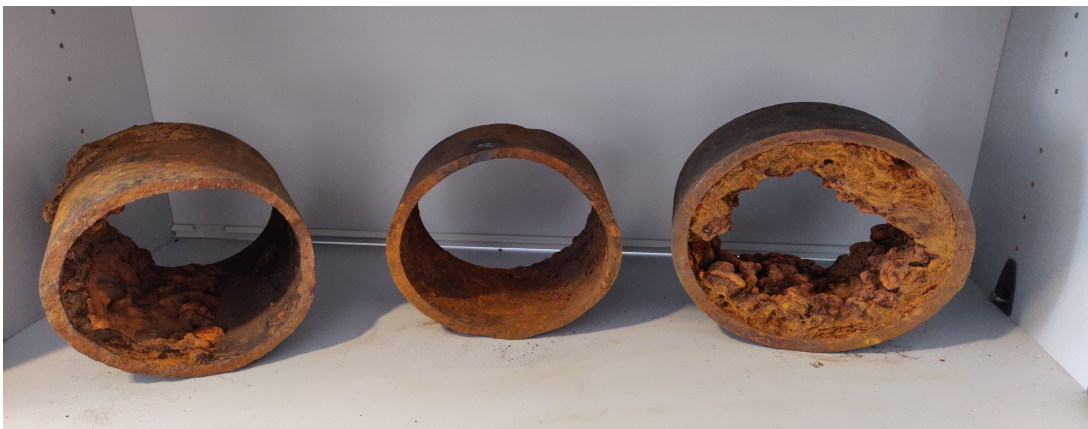
Figur 14: Et eksempel på redusert hydraulisk kapasitet i rør på grunn av sedimenter og rust. Bergen vanns museum
