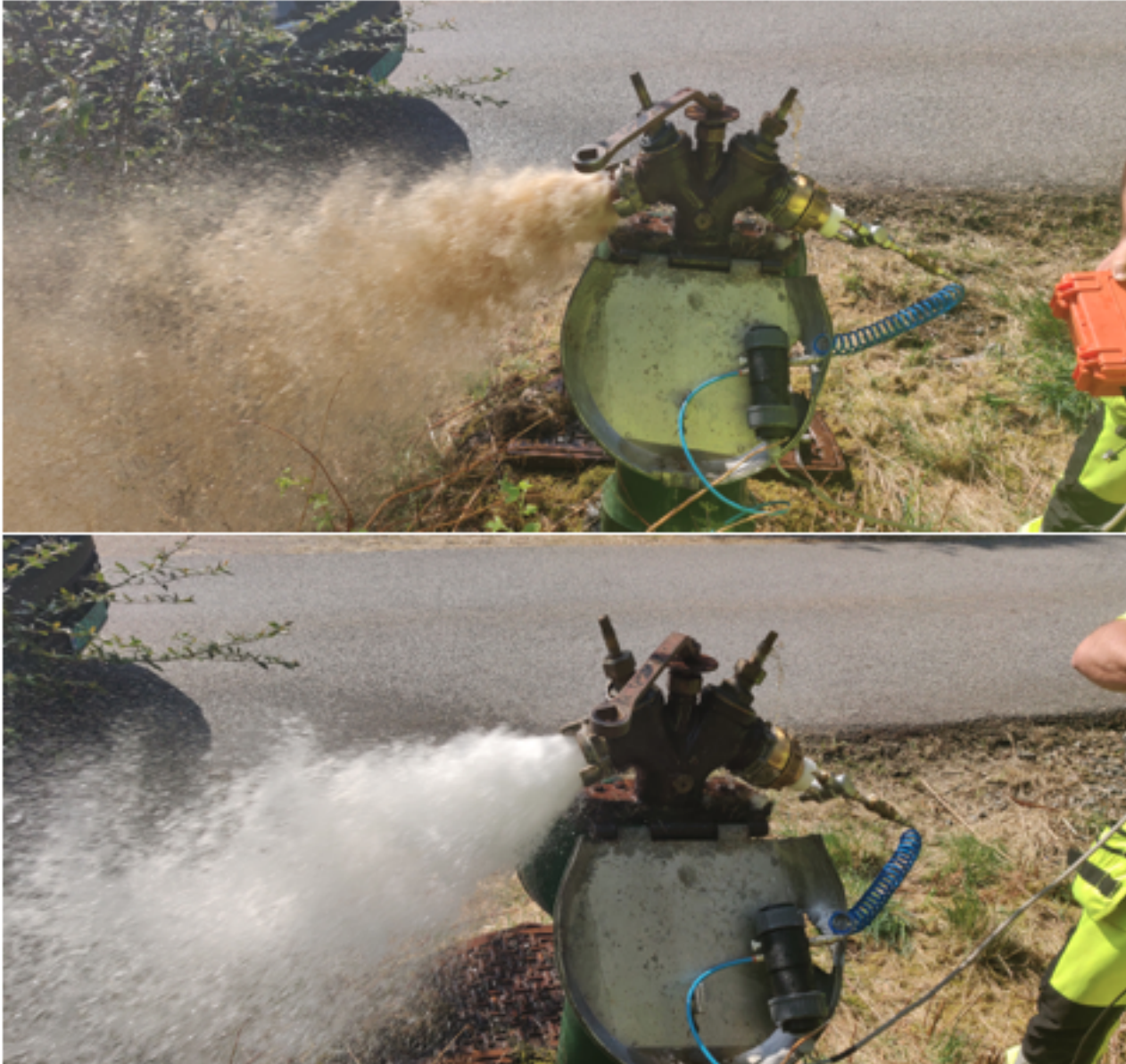
Figur 20: Viser forskjellen på vannet før og etter spyling. Foto: Kassem Ali Al-Sheikh
