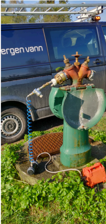
Figur 22: Turbiditetsmåling ved hydrant. Foto: Kassem Ali Al-Sheikh. Illustrasjon: Bergen vann.
