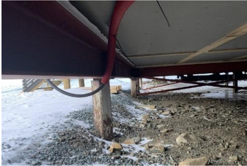
Figur 2-5: Stålpeler under The Vault, foto: H. Kvalsund
