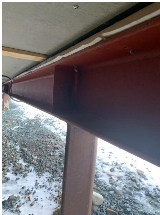
Figur 3-22: HEB-ramme og HUP-peler, foto: E. Vabø
