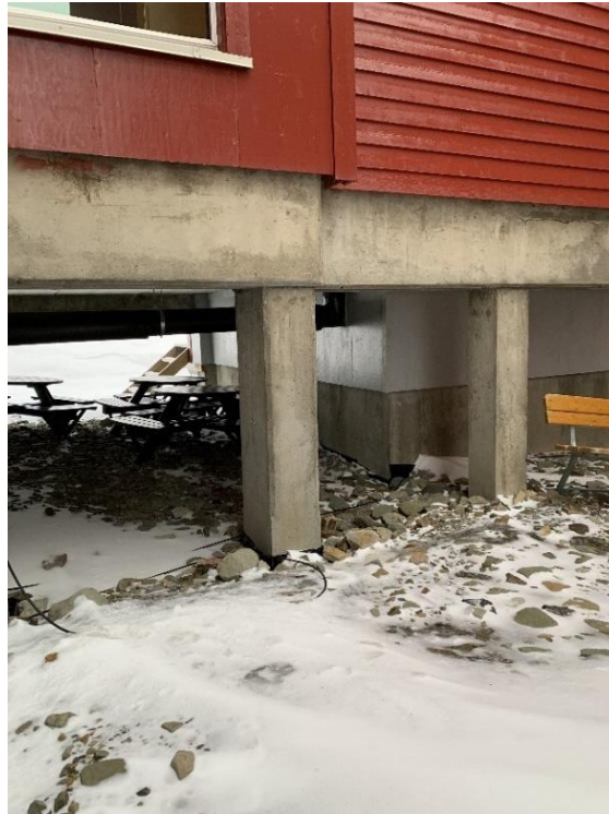
Figur 3-4: Sålefundamentering under Funken Lodge, foto: E. Vabø
