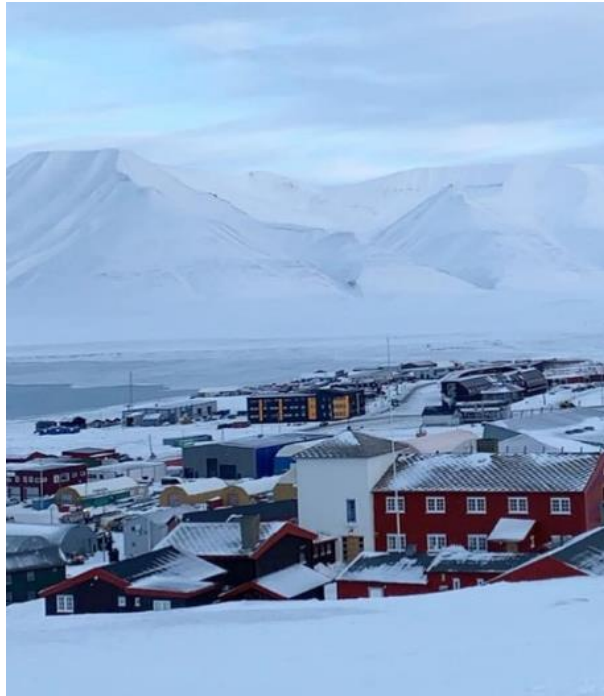
Figur 4-1: Snøsituasjon på tak, foto: E. Vabø
