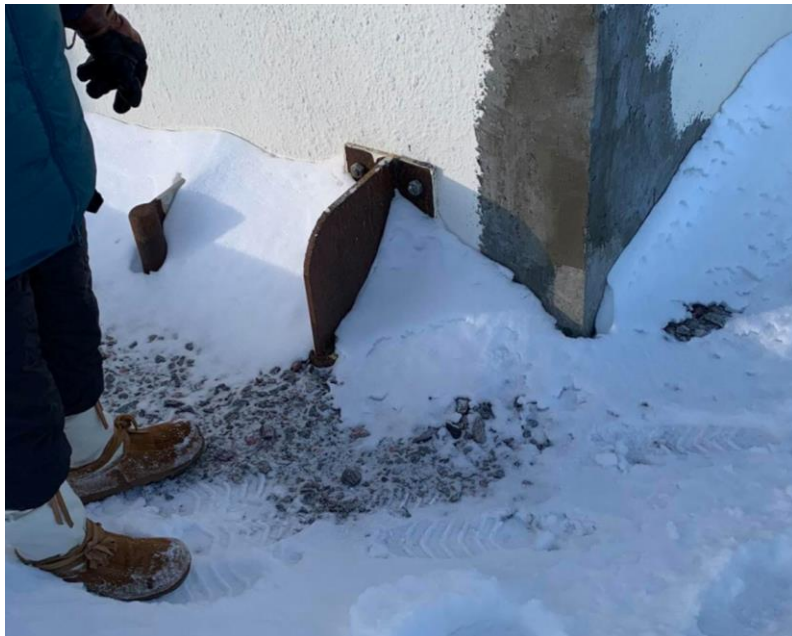
Figur 3-10: Ettermontert stålpel i knust hjørne på Sysselmannsgården, foto: E. Vabø
