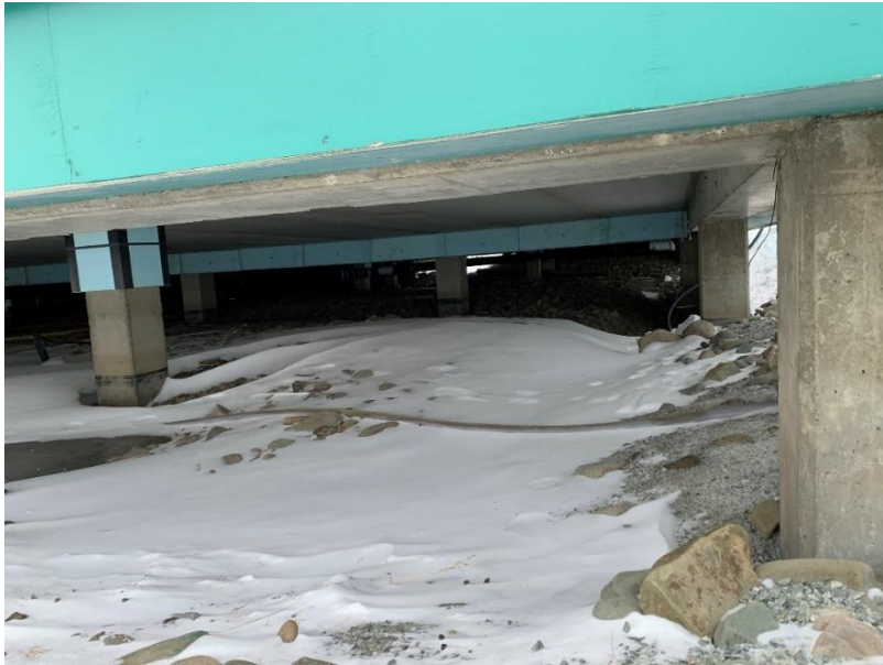
Figur 2-2: Sålefundamentering under Svalbardhallen, foto: E. Vabø
