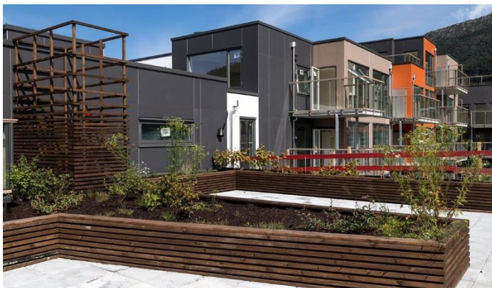
Figur 46. Takterrasse i Inndalsveien. Kilde: [40].
