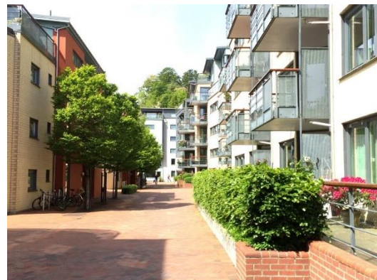
Figur 8. Eksempel på nivåforskjell. Georgernes Verft, Bergen. Kilde: [26]
