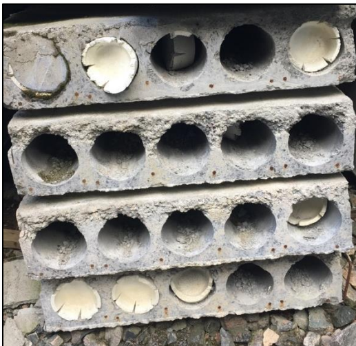
Figur 3.4: Hulldekke 265 med 8 spenntau.
