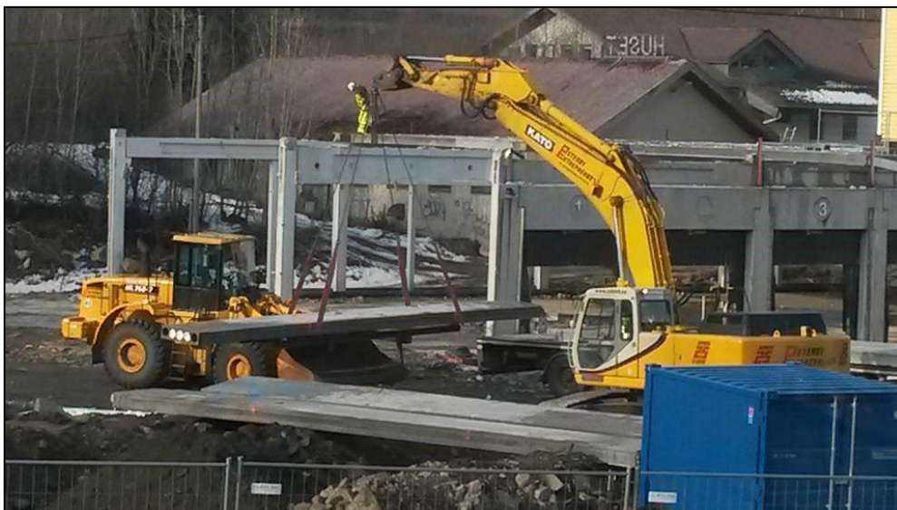
Figur 3.2: Rivning av det gamle ASKO bygget på Midtun.
