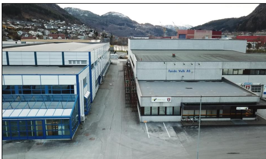
Figur 40 - Mellom bygga her er det fremma forslag om ny køyreveg for lastebil. Foto: Privat
