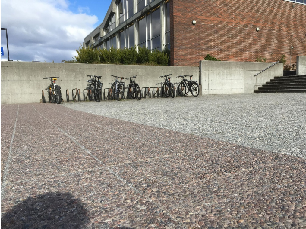
Figur 3.16: Parti av plassen utanfor hovudinngangen på Førdehuset. Dei nye tunhellene vart i ein annan fargekontrast enn det opphavelge.
