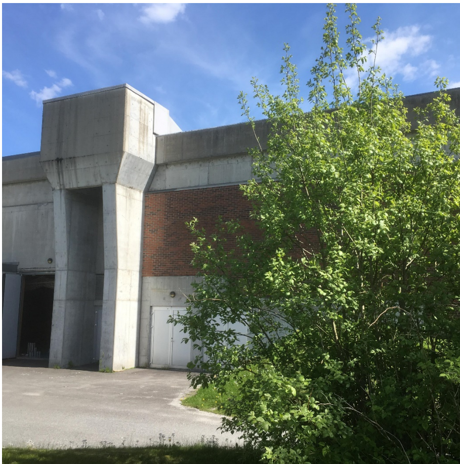
Figur 2.2: Vestveggen til idrettshallen. Brutalistisk stil er vidareført etter påbygg i 1996.
