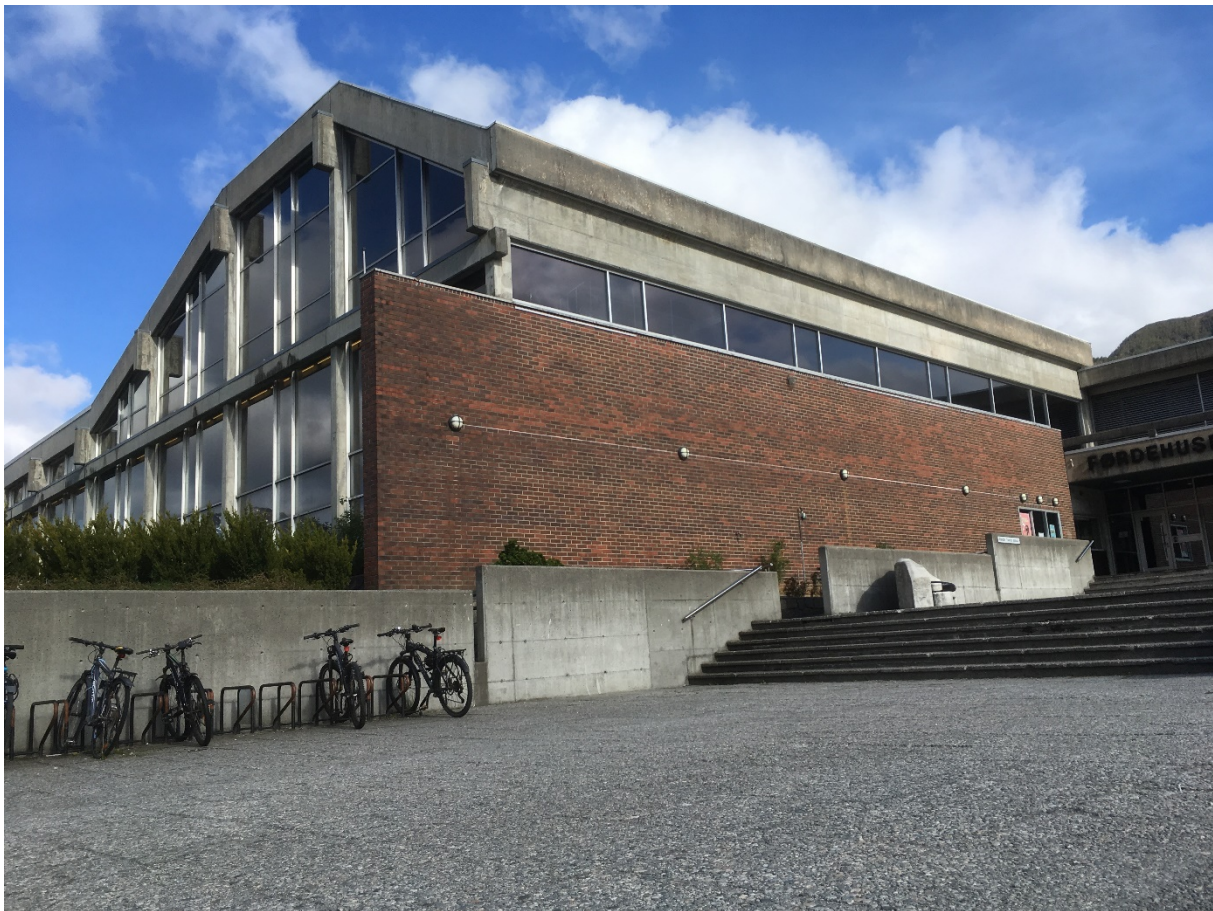
Figur 3.14 Bilete av teglvegg sett frå aust. Fotograf: Viggo Leikanger.
