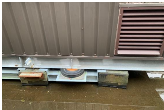
Figur 45: støtdempere varmeanlegg
