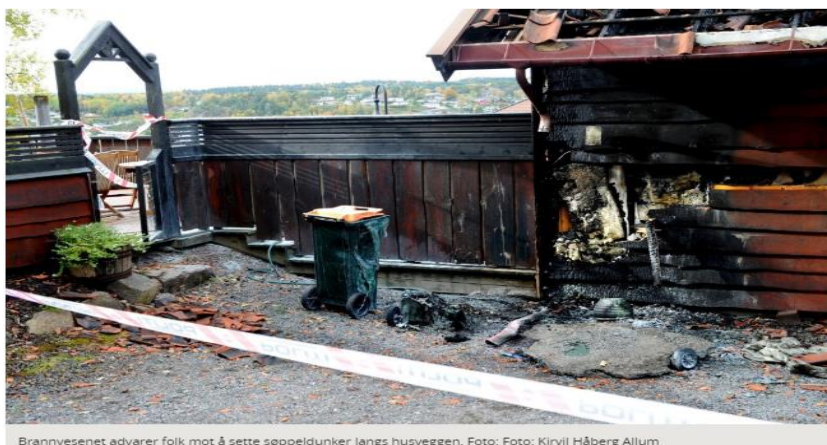
Brannvesenet advarer folk mot å sette søppeldunker langs husveggen. Foto: Foto: Kirvill Håberg Allum
