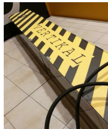
Figur 2 - Vertikalt rør bygget inn i kasse
