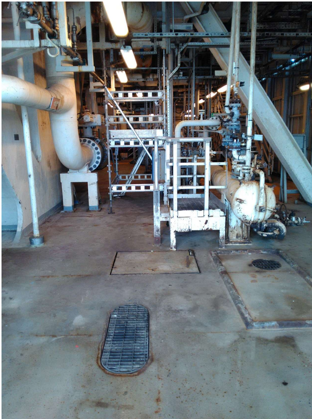
Figur 36 Mottakersluse for Tor på C-13 (Foto tatt av gruppen med tillatelse fra ConocoPhillips)
