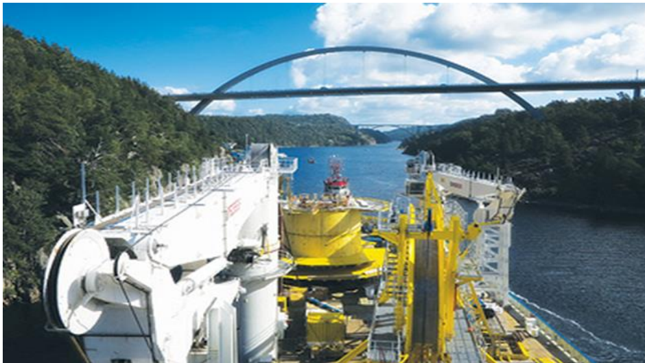
Figur 7. North Sea Giant, Kraner som blokkerer sikten
